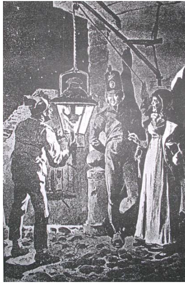
Figura 2.1: Iluminação Pública em Portugal no Séc. XIX. [2, p. 70].
