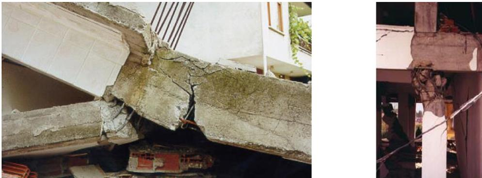
Figura 8 – Mecanismo viga forte-pilar fraco.
