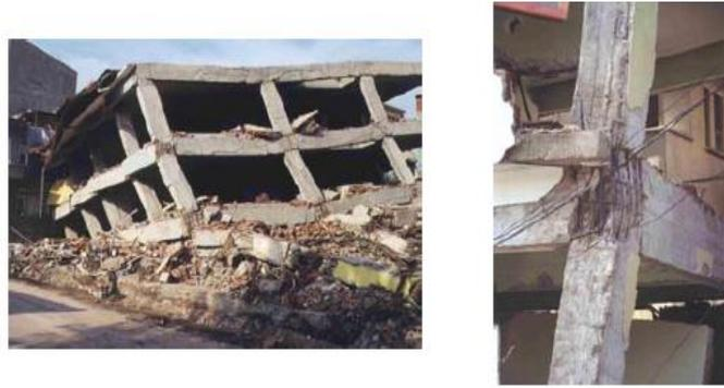
Figura 6 – Falhas no projeto de ligações viga-pilar.
