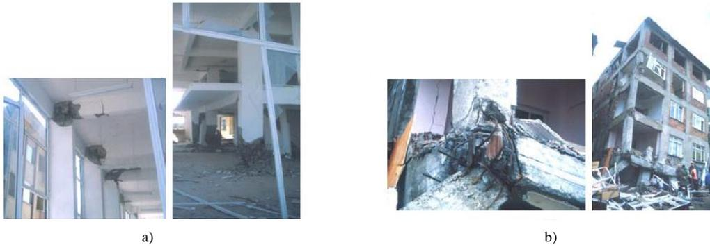
Figura 7 – Inadequada resistência dos nós: a) danos nos nós; b) rotura nos nós.
