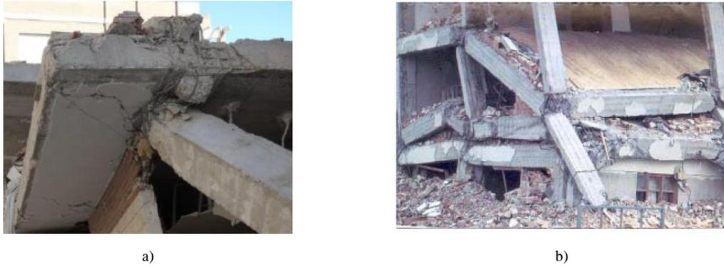
Figura 4 – Rotura de nós viga-pilar devido a má execução de projeto: a) Lorca, Espanha 2011; b) Izmit, Turquia 1999. (Varum, 2003)
