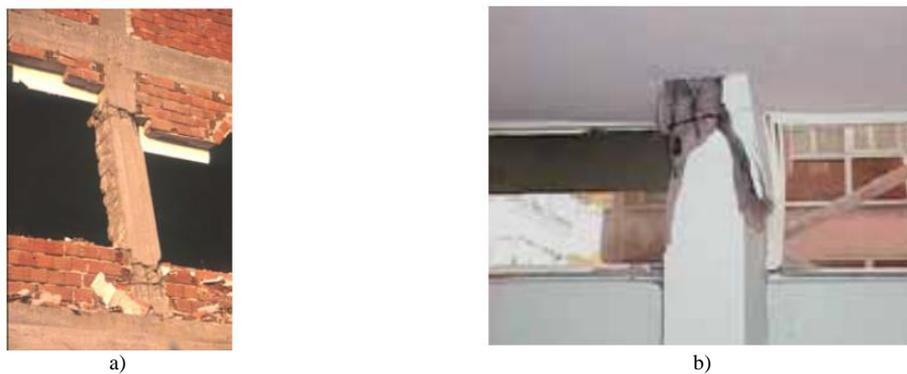
Figura 2 – Danos devidos a: a) efeito do mecanismo pilar curto; b) falta de armadura transversal. (Aschheim, 2001)
