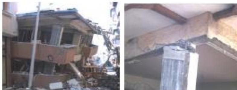
Figura 10 – Escorregamento de armaduras em pilares.
