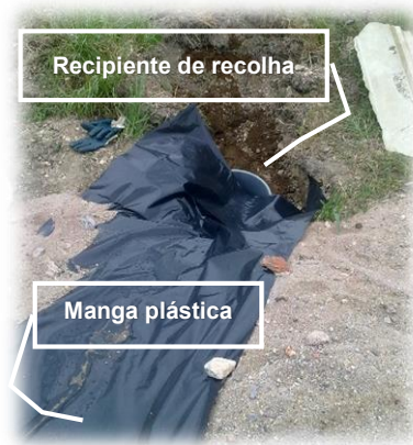
Figura 12- Manga e recipiente de recolha da água de escorrência superficial.
