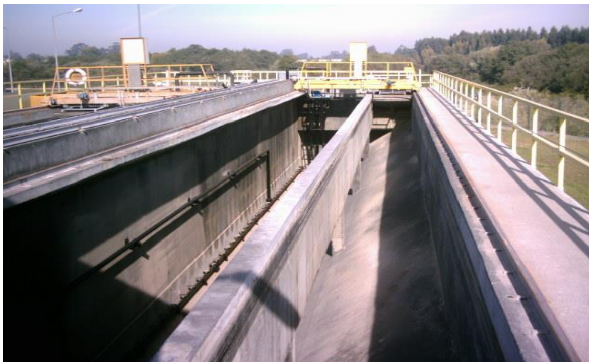
Figura 9 - Desarenador/desengordurador
