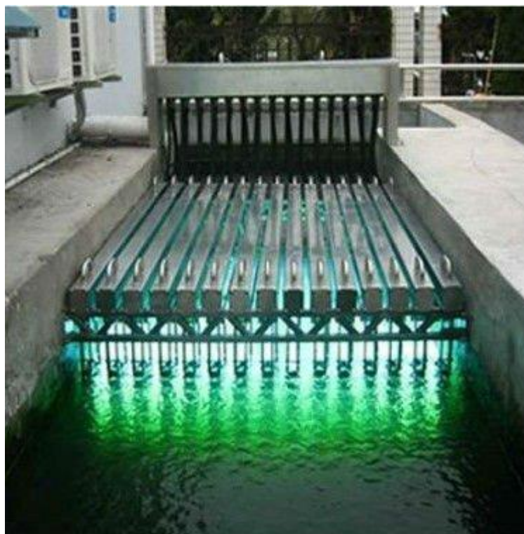
Figura 15 - Equipamento de desinfeção por UV
