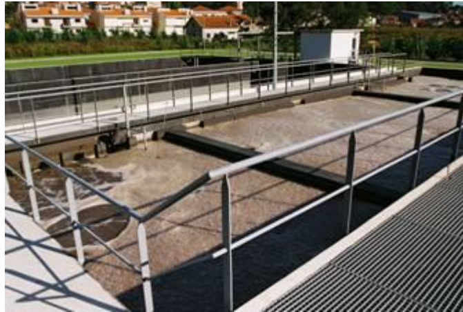
Figura 13 - Tanque de arejamento
