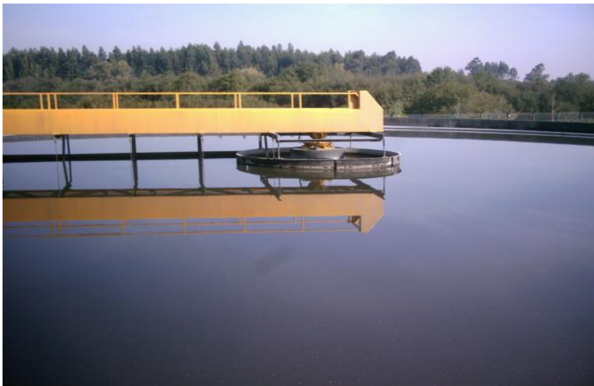
Figura 11 - Decantador primário
