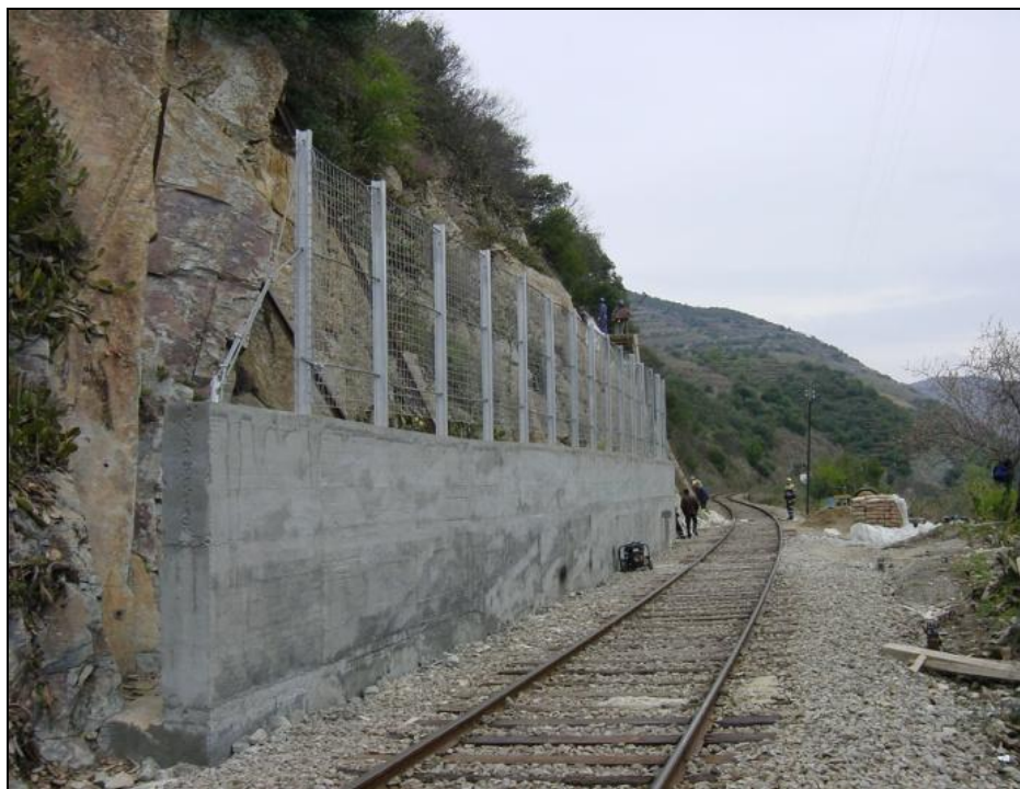
Figura 2.29 – Barreira rígida para proteção da circulação ferroviária existente na Linha do Douro.
