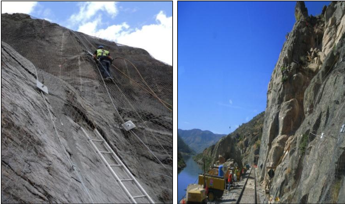
Figura 2.23 – Desenvolvimento das obras de estabilização de taludes na linha do Douro, 2010.
