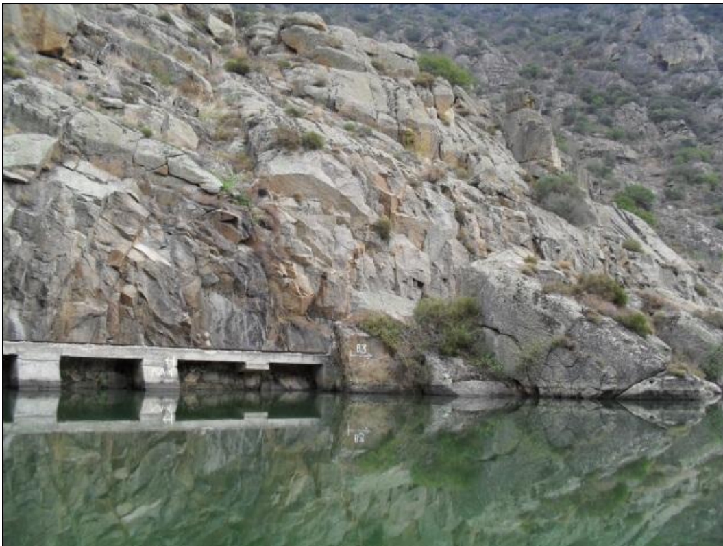
Figura 3.7 – Vista geral do talude 1.
