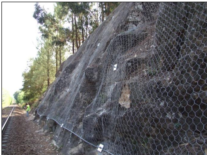
Figura 2.22 – Redes pregadas, na linha do Douro, 2009.
