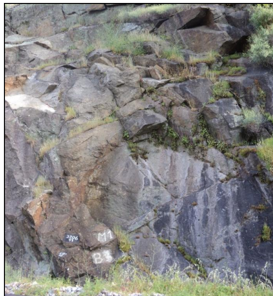
Figura 3.16 – Vista das descontinuidades no talude 2.
