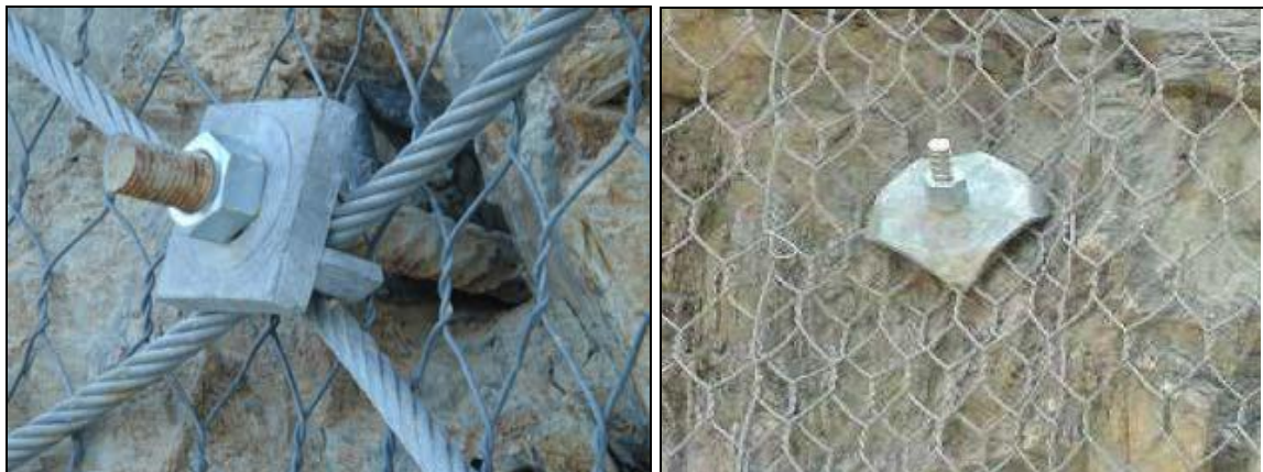
Figura 2.26 – Exemplos de diferentes sistemas de aperto de pregagens.
