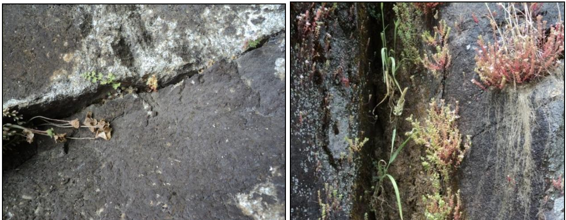
Figura 3.5 – Aberturas, rugosidade e preenchimento observadas nos taludes.
