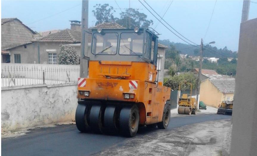
Figura 39 - Compactador de pneus e compactador de cilindro (fotografia pessoal)
