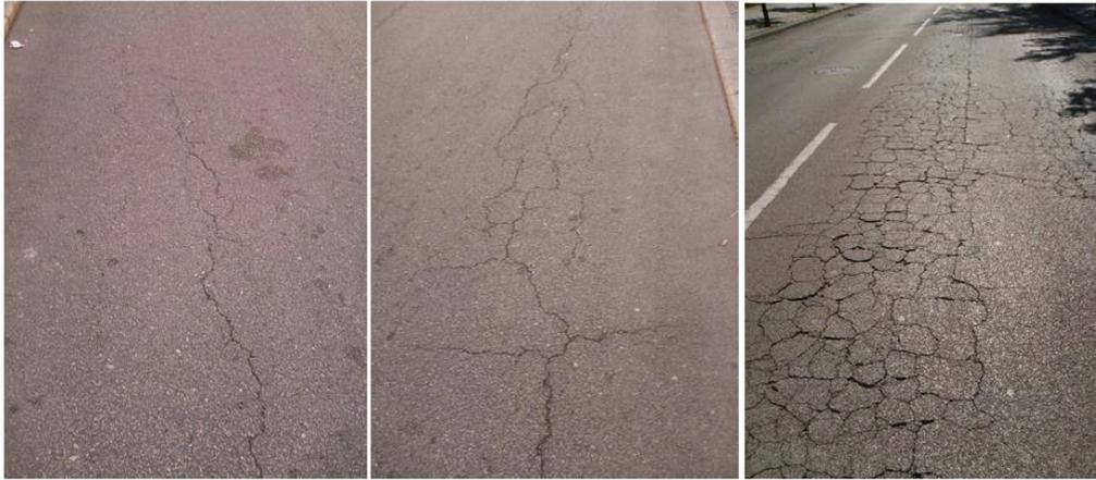
Figura 4 - Fendas longitudinais (esquerda), fendas ramificadas (meio) e “pele de crocodilo” (direita)
