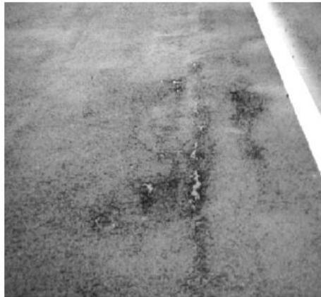
Figura 5 - Degradação superficial de um pavimento
