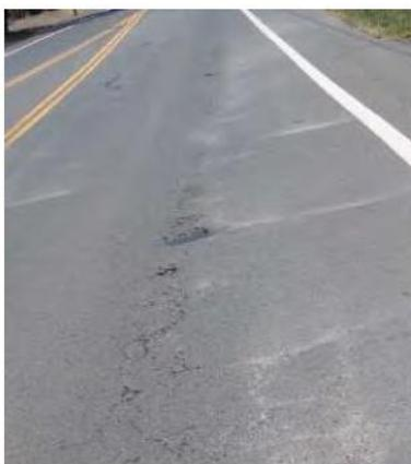
Figura 7 - Movimento de materiais finos para a superfície do pavimento
