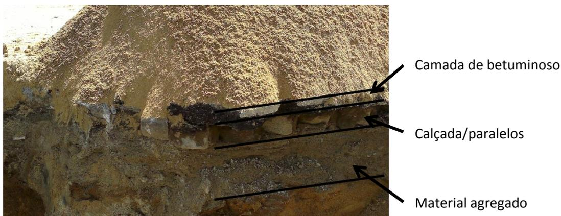
Figura 36 - Zona do pavimento que apresenta camada de betuminoso e calçada/paralelos (fotografia pessoal)
