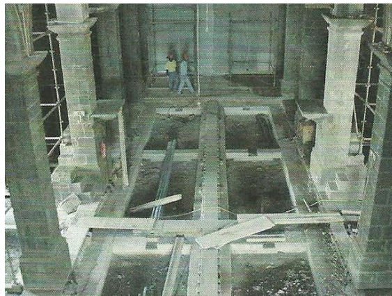
Figura 36. Vista geral das fundações da nave central da igreja da Madalena (Arêde et al., 2008).
