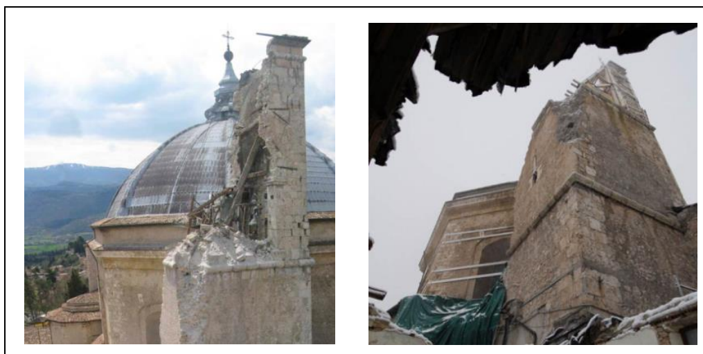
Figura 24. Maiores danos exteriores provocados pelo sismo de L'Aquila (ICIET Engineering srl, 2010).
