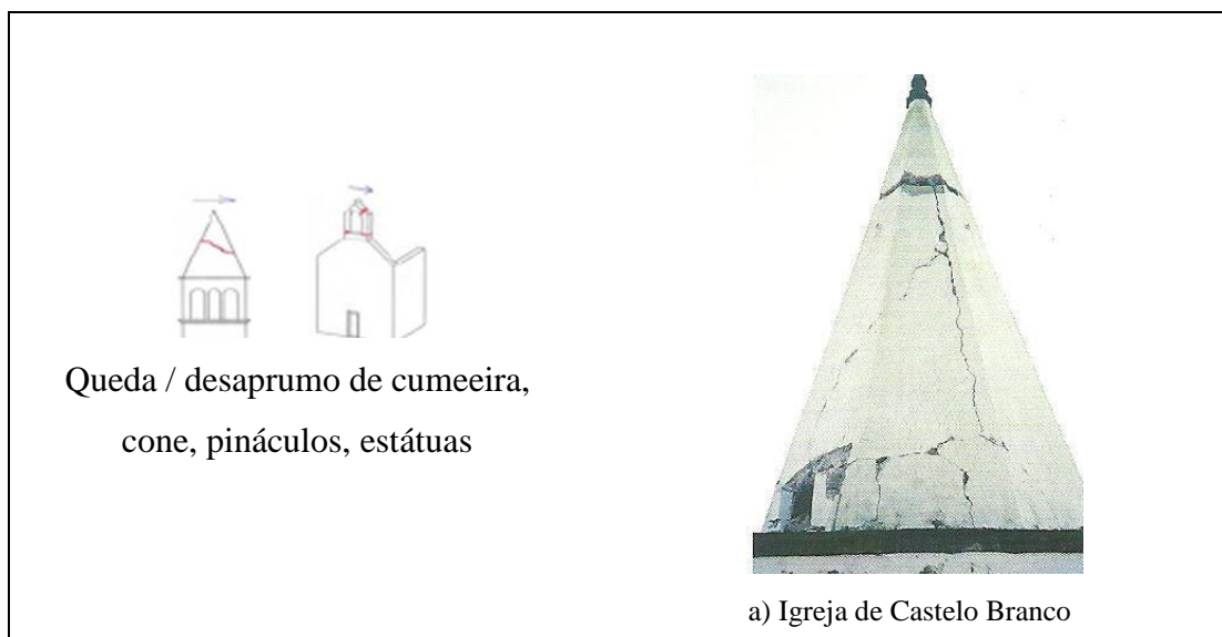
Figura 13. Mecanismos de queda de pináculos (Azevedo & Guerreiro, 2008)
