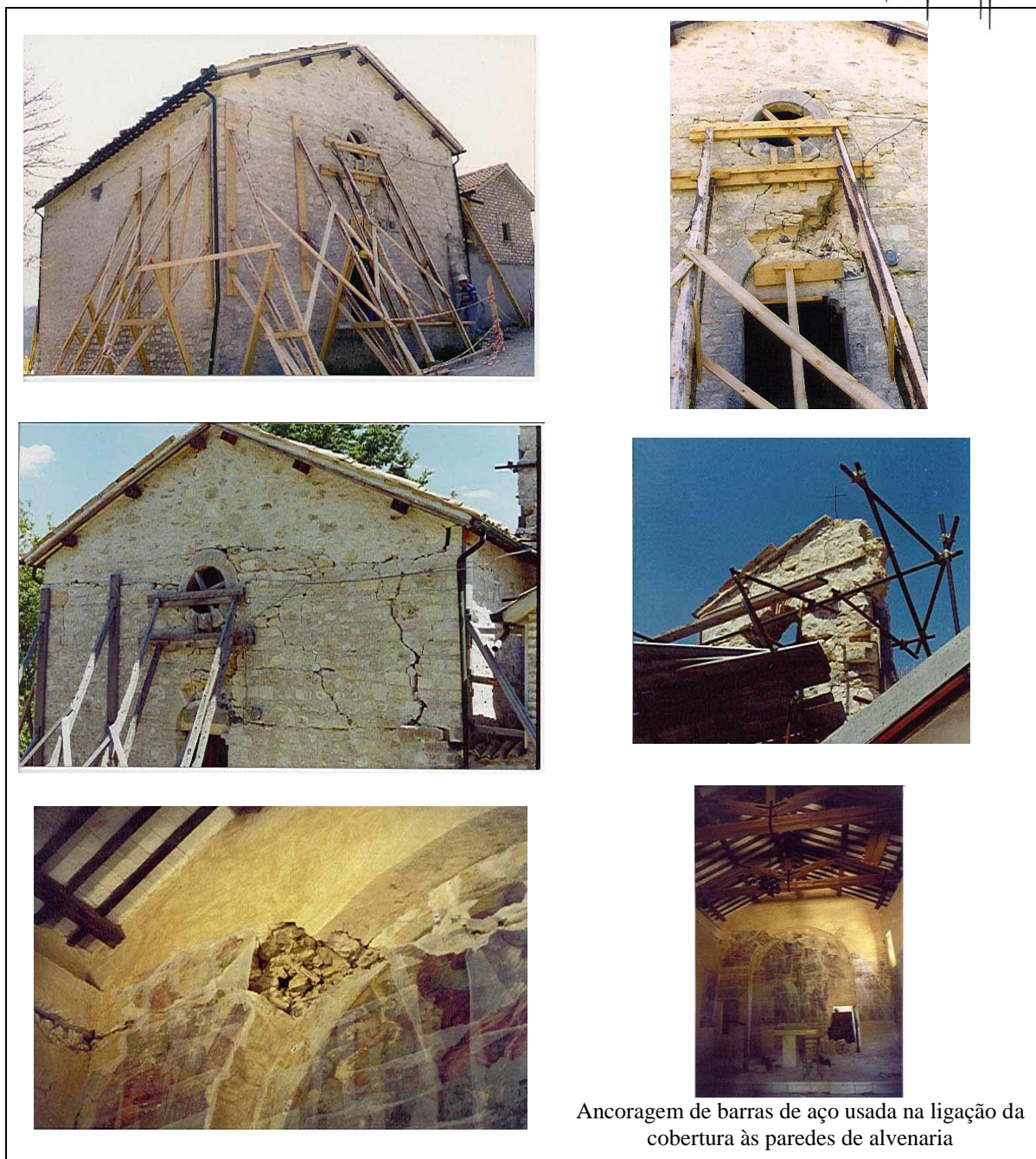
Figura 21. Síntese dos danos exteriores e interiores provocados na igreja de San Giovanni Battista pelo sismo de 1997, com aplicação das estruturas de emergência para garantir a estabilidade, compostas por andaimes de construção (Indirli et al., 2004).
