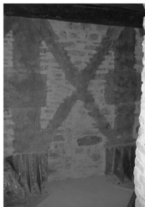
Figura 19. Instalação dos compósitos FRP na base de ancoragem (Cosenza et al., 2003).
