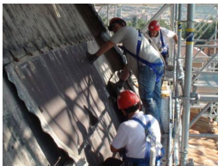
Figura 26. Aplicação de bandas de fibras de carbono (ICIET Engineering srl, 2010).
