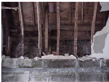
Figura 34. Apoios intermédios da estrutura da cobertura (A. Costa & Vasconcelos, 1999b).
