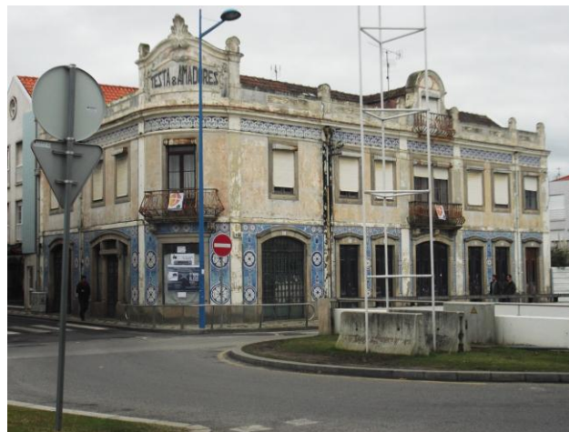
Figura 26. Fachada do edifício Testa e Amador em Aveiro.
