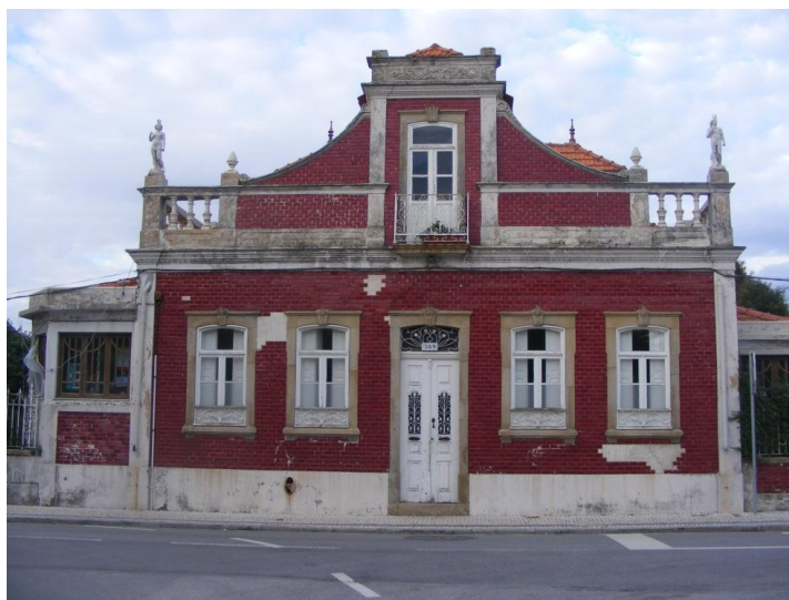
Figura 32. Fachada do edifício situado no Largo S. Miguel, Ovar
