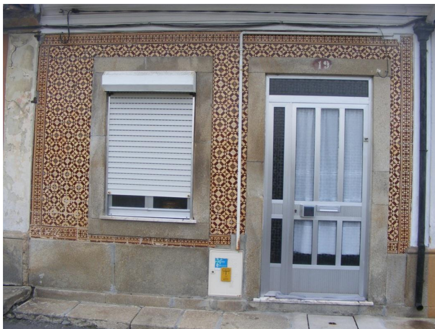
Figura 41. Fachada do edifício situado na Rua Vasco da Gama, Ovar
