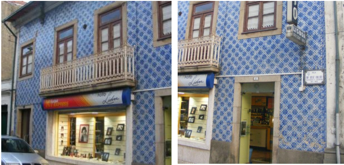
Figura 71. Apresentação da fachada 10 situada no Largo dos Bombeiros, Ovar
