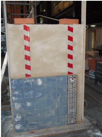
Figura 90. Parede com fitas plásticas colocadas entre o reboco e o revestimento.
