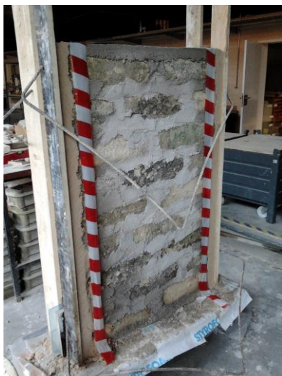
Figura 88. Parede com fitas plásticas colocadas entre o suporte e o reboco.
