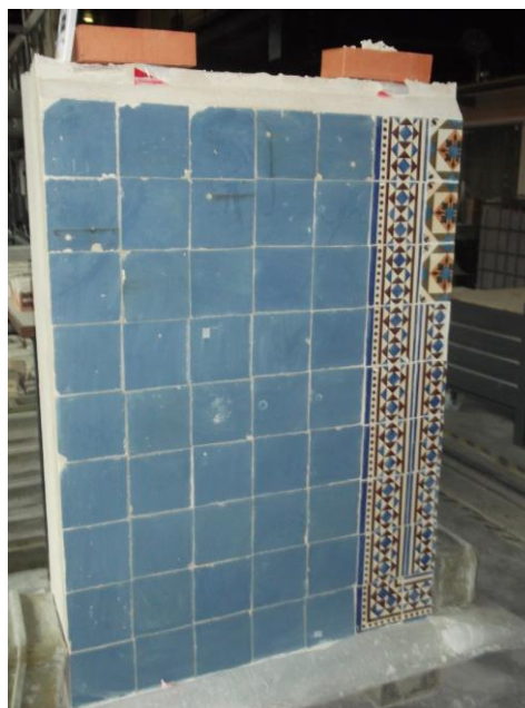
Figura 92. Aspeto final da parede com azulejos antigos e réplicas.
