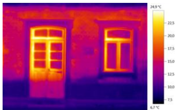
Figura 37. Imagem termográfica geral da fachada 3.
