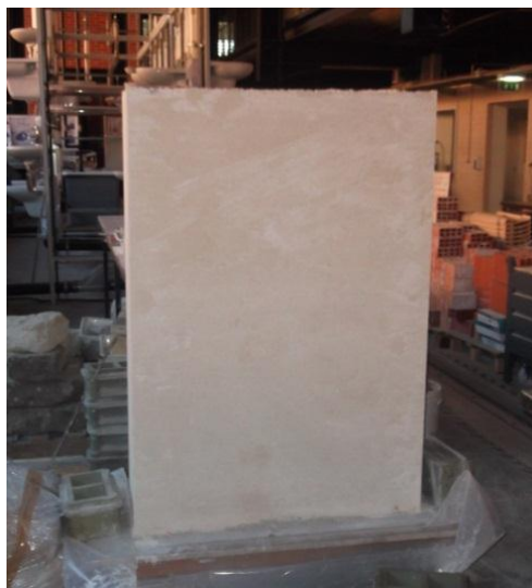
Figura 89. Aspeto da parede após aplicação do reboco.
