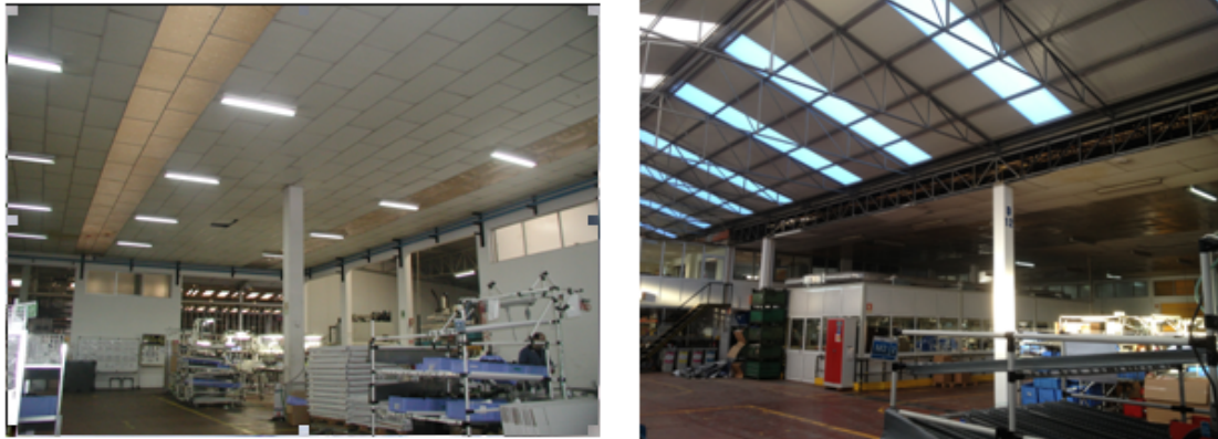
Figura 23 - Teto fabril do Armazém do Produto Acabado (Antes e Depois)
