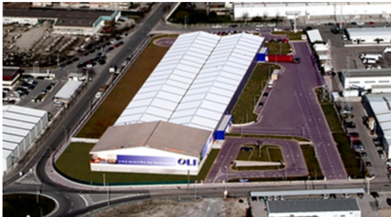
Figura 13 - Armazém Zona Industrial de Aveiro – AZIA (OLI, 2013)
