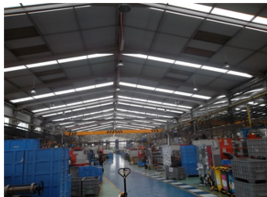
Figura 24 - Teto fabril do parque industrial da Oliveira & Irmão, S.A.
