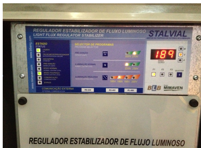
Figura 21 - Regulador de fluxo luminoso Stalvial
