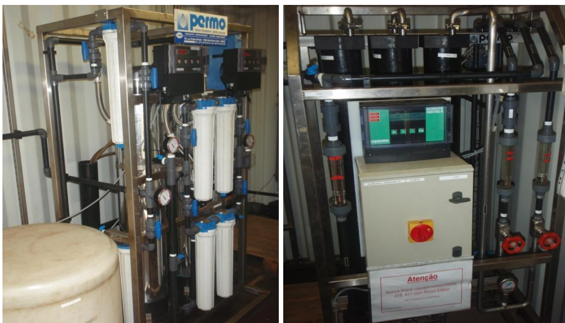
Figura 2.6 – Desmineralização com descalcificador e osmose inversa.
