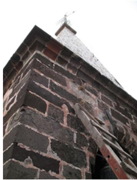
Fig. 4.12 Alçado norte da Torre sineira da Sé do Funchal
