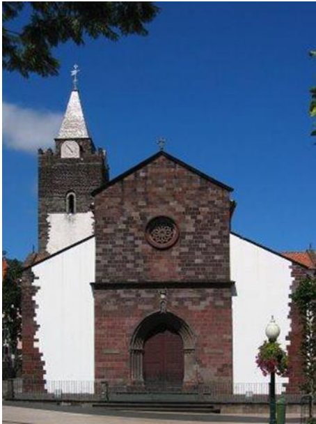
Fig. 4.11 Fachada principal da Sé do Funchal
