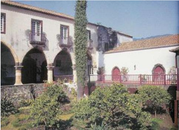
Fig. 4.4 Mosteiro e Convento de Santa Clara, Funchal
