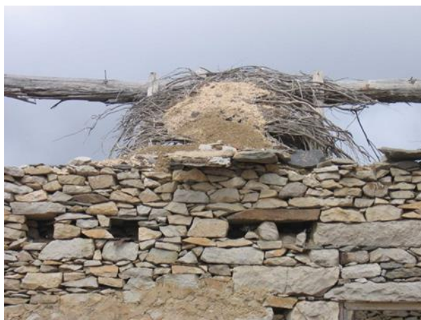
Fig. 4.3 Pormenor de aplicação dos materiais na cobertura numa casa de salão no sítio das Eiras, ilha do Porto Santo
