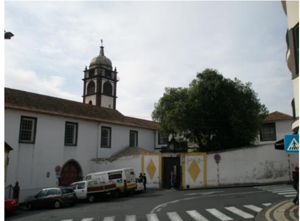
Fig. 4.5 Torre sineira do Mosteiro Convento de Santa Clara
