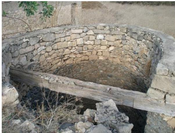
Fig. 4.20 Nora da Lagoa, localizada no sítio na Lagoa, Porto Santo
