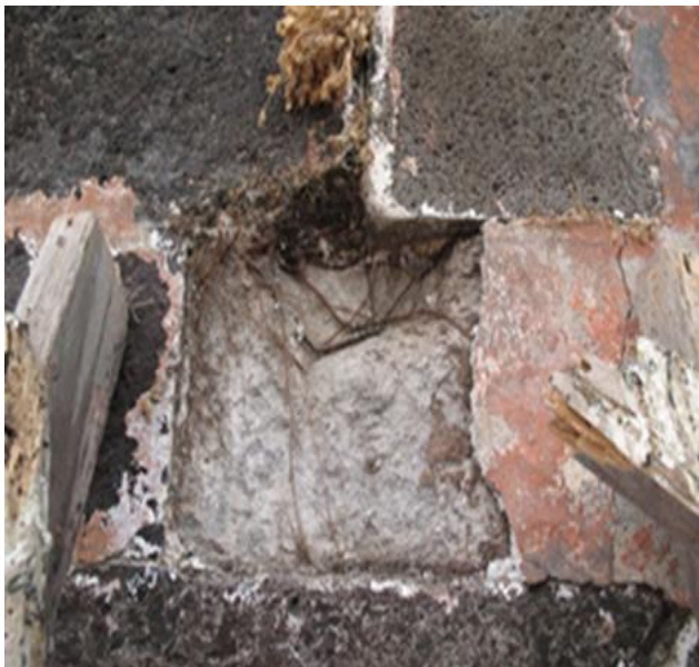
Fig. 4.13 Pormenor do revestimento das argamassas sobre a pedra natural da torre sineira da Sé do Funchal
