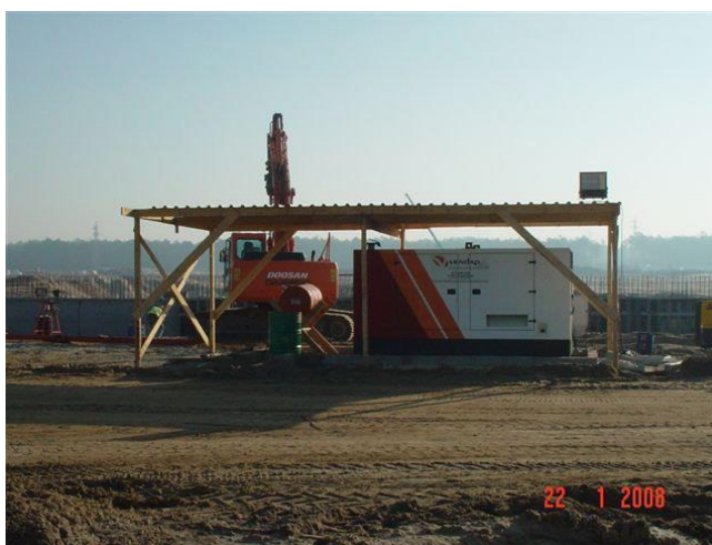
Figura 25 - Criação de uma cobertura para o gerador
