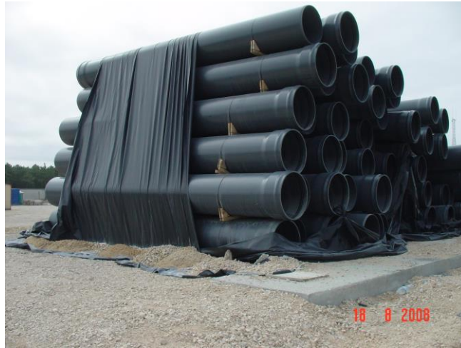
Figura 119 - Armazenamento provisório de tubagem
