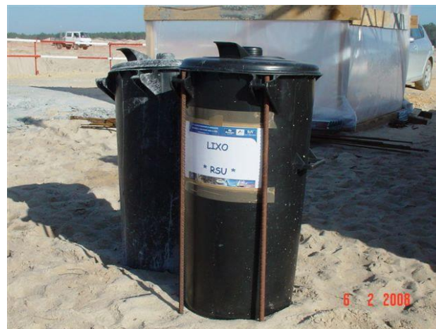
Figura 18 - Contentor do RSU nas frentes de trabalho
