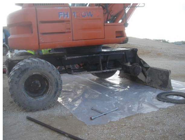
Figura 127 - Manutenção de equipamento
