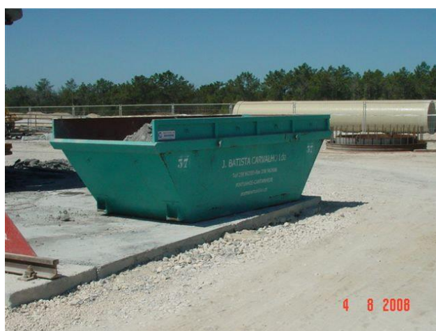
Figura 21 - Contentor de resíduos de betão
