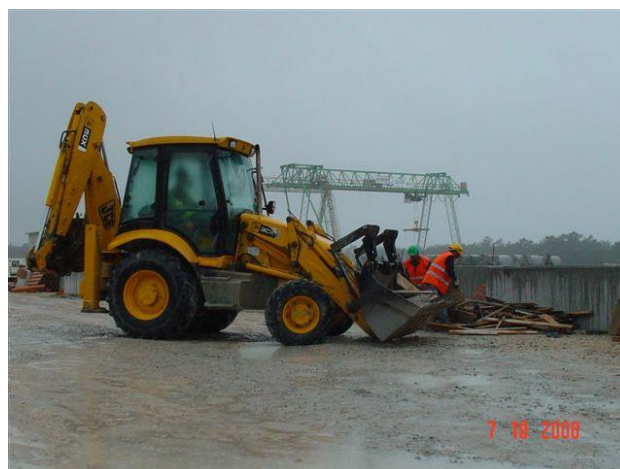
Figura 124 - Recolha de madeira nas frentes de obra
