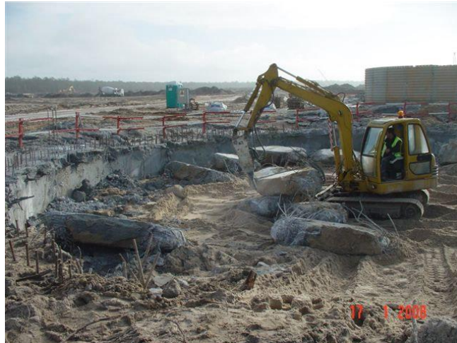
Figura 116 – Trabalho de demolição
