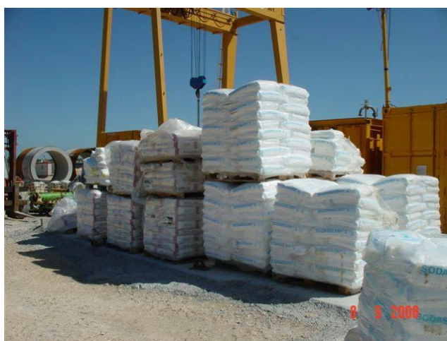
Figura 28 - Área de armazenamento impermeabilizada
