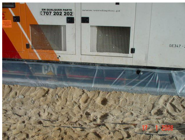
Figura 24 - Colocação dos geradores sobre bacia de retenção
