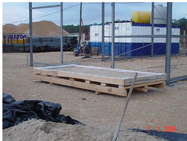
Figura 29 - Montagem de bacia de retenção para colocação de geradores
