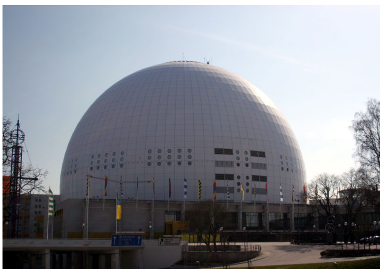
Figura 1.10: Stockholm Globe Arena, este é um exemplo de aplicação de estruturas sanduíche na construção civil, onde para além de uma baixo peso estrutural tem benefícios no isolamento térmico e acústico.
