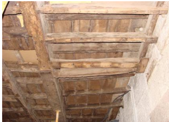
Figura 36 – Flechas provocadas pelo assentamento da viga principal (Portaria do Mosteiro de Pombeiro, Felgueiras) [Martins, 2009].
