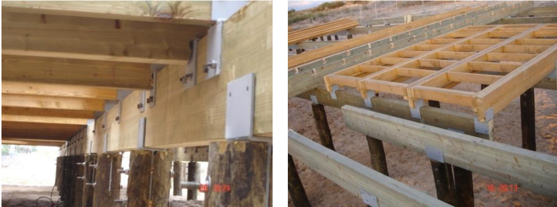
Figura 56 – Exemplo do tipo de ligações utilizadas nas fundações
