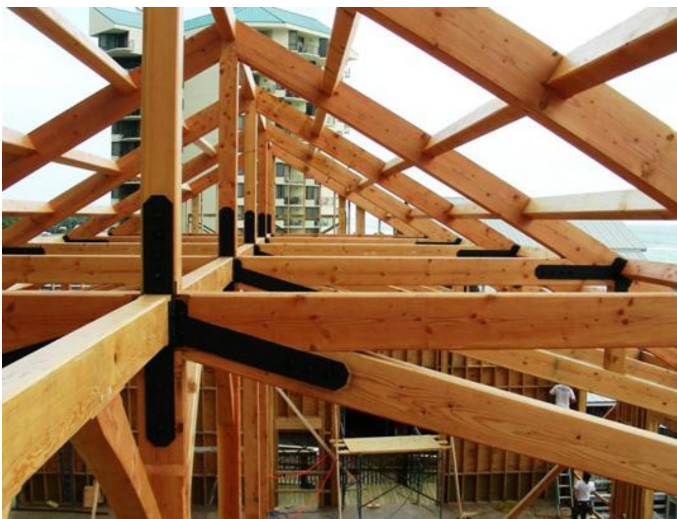
Figura 45 – Estrutura atual em madeira com reforços metálicos [ www.wngenhariacivil.com ]
