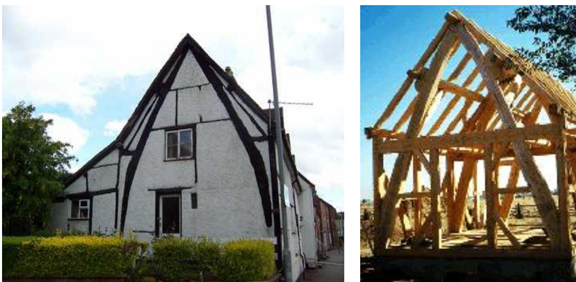
Figura 11 – Exemplos atuais de construção de estrutura em A ( cruck frame ) no Reino Unido [ www.blackandwhitehouses.co.uk ; www.woodlands.co.uk ]
