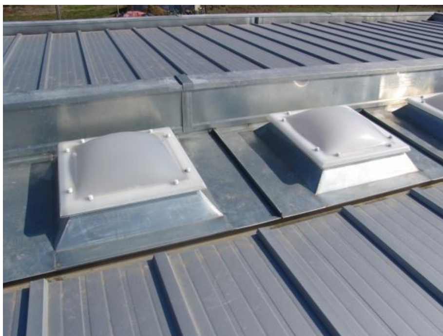
Figura 59 – Aspeto da cobertura
