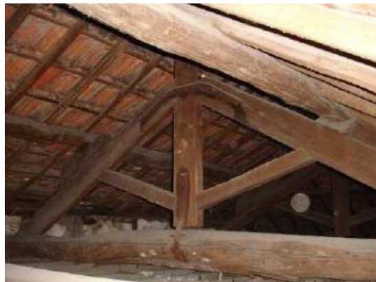
Figura 16 – Exemplo de asna de madeira do início do séc. XX [Feio, 2007]
