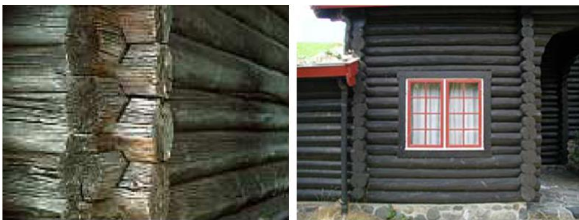
Figura 5 – Habitação tradicional em estrutura de madeira de troncos sobrepostos [www.finland.fi; www.svalebaek.dk]
