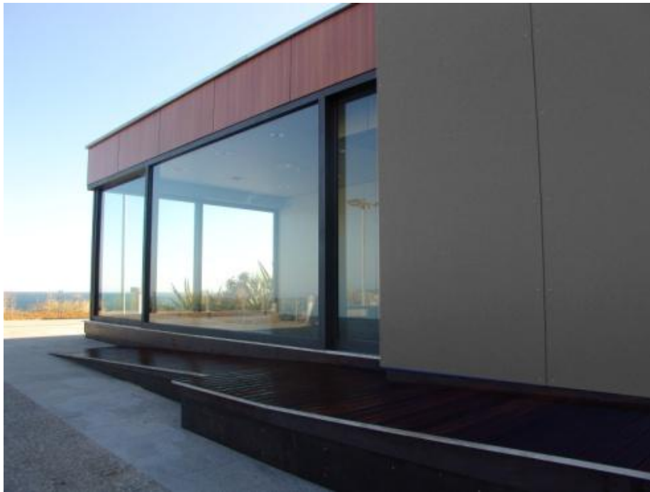
Figura 58 – Base de fundação
