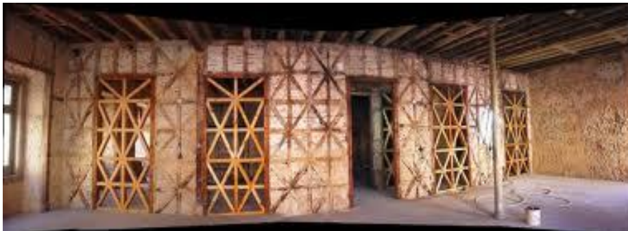
Figura 14 – Tipologia de parede tipo pombalino [ http://forumdacasa.com ]
