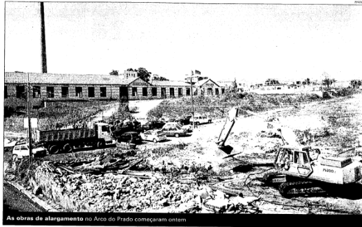
As obras de alargamento no Arco do Prado começaram ontem
