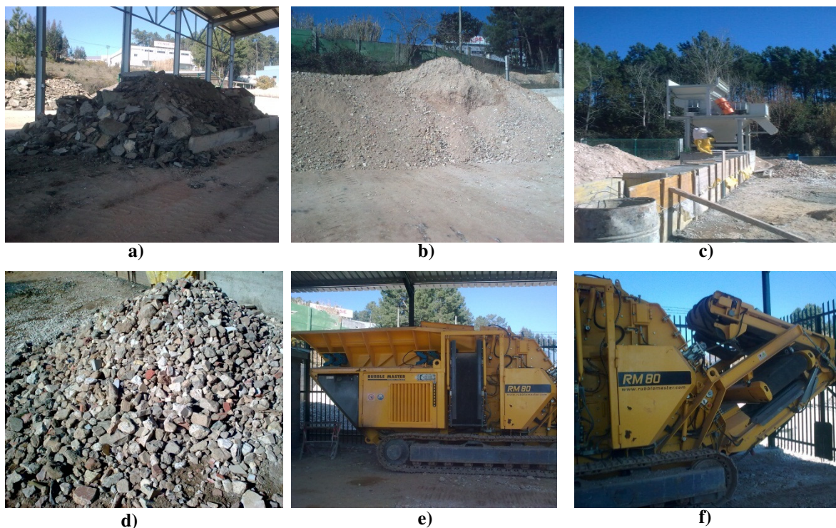
Figura 2. Fotos da central de reciclagem Ambilei: a) RCD betuminoso; b) RCD armazenado; c) Crivo; d) RCD crivado; e) Separadora magnética; f) Pormenor dos tapetes da separadora magnética
