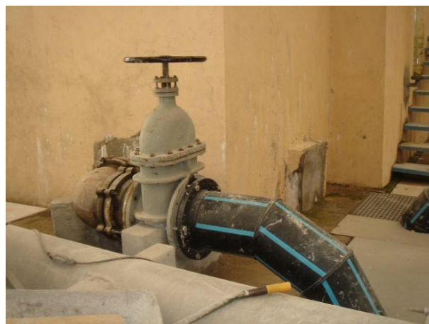
Figura 17. Válvula de cunha
