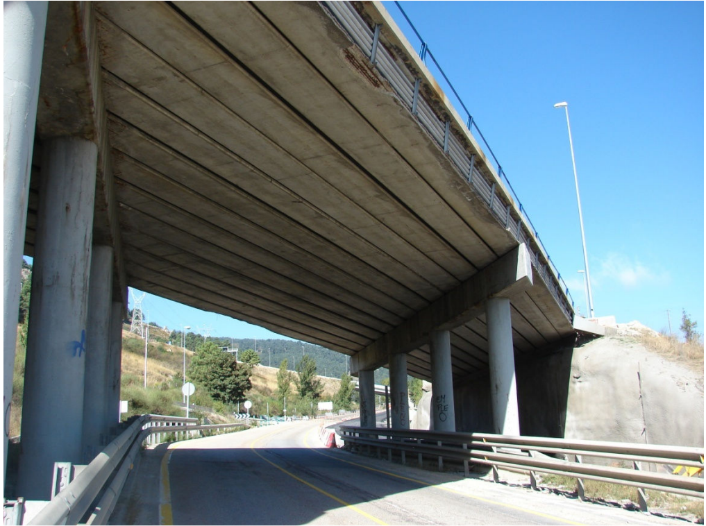
Figura 14: Vista inferior da Passagem Superior no p.k. 6 + 090
