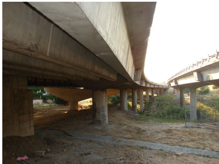
Figura 17: Vista das duas estruturas à data da realização dos trabalhos de campo
