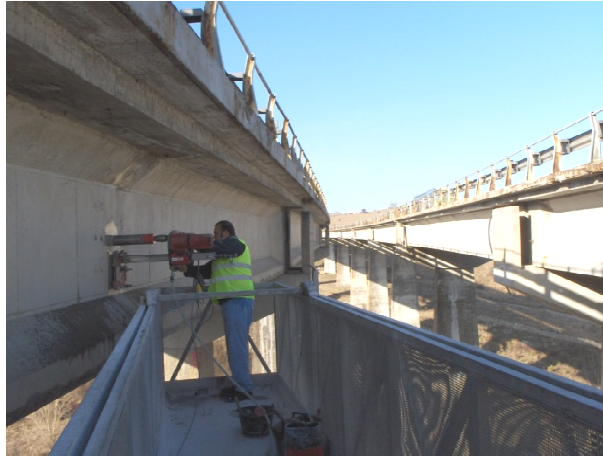
Figura 51: Extração de carotes no viaduto localizado no p.k. 19 + 090.
