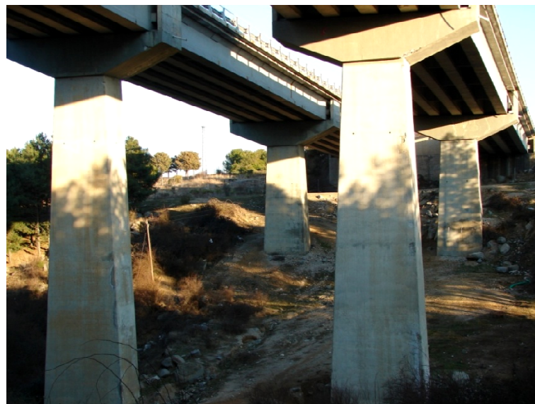
Figura 34: Vista inferior dos Viadutos
