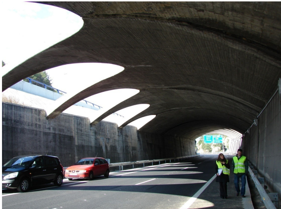
Figura 11: Vista geral da estrutura
