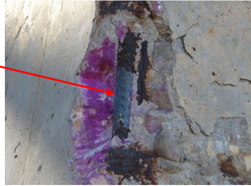
Figura 65: Detalhe de uma zona em bom estado.
