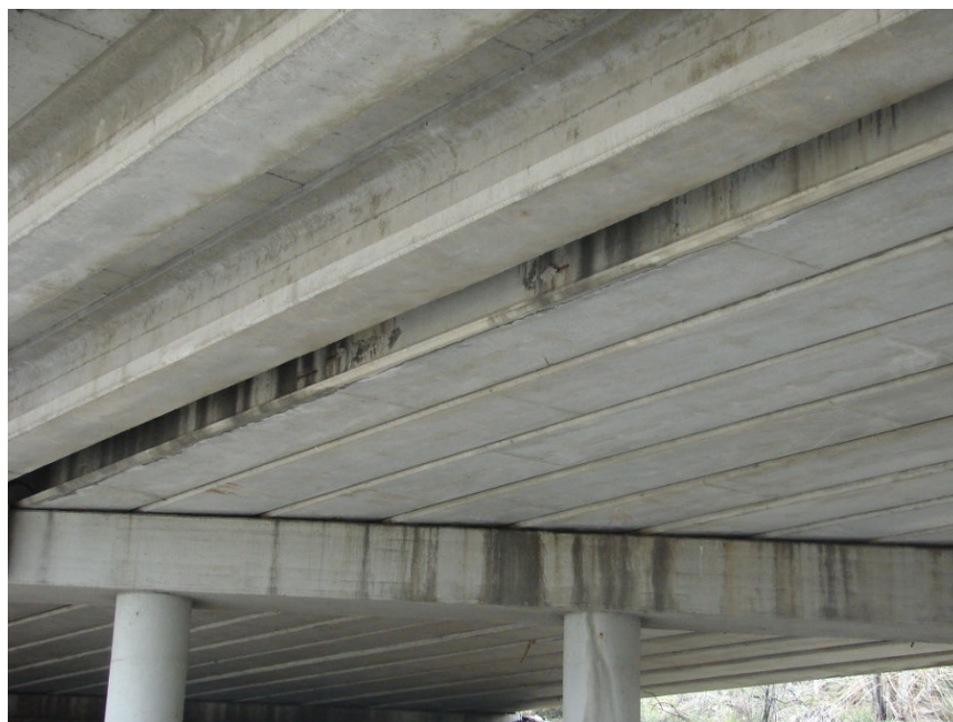
Figura 5: Alçado lateral e vista inferior de uma das Passagens Superiores no p.k. 0 + 000
