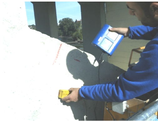
Figura 69: Detecção das armaduras, através da utilização de um pacómetro.
