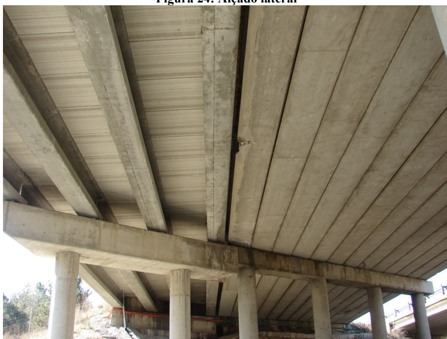
Figura 25: Vista inferior de uma das estruturas
