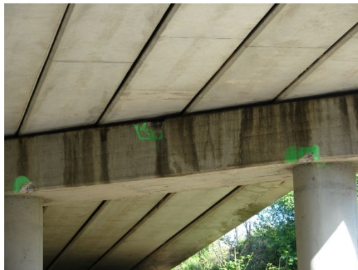
Figura 56: Estado de um capitel de um pórtico intermédio.
