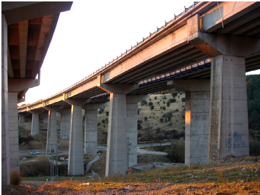
Figura 9: Vista de um alçado lateral de um dos viadutos
