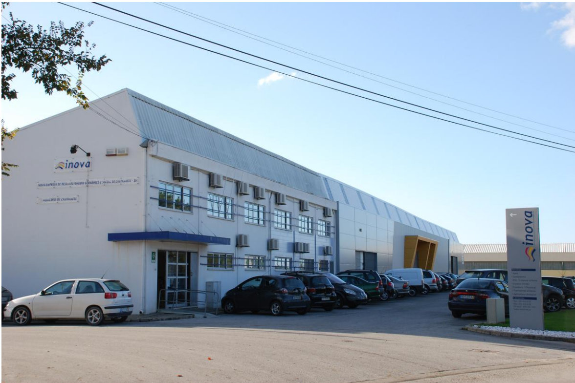
Figura 12 - Instalações sede da INOVA-EEM
