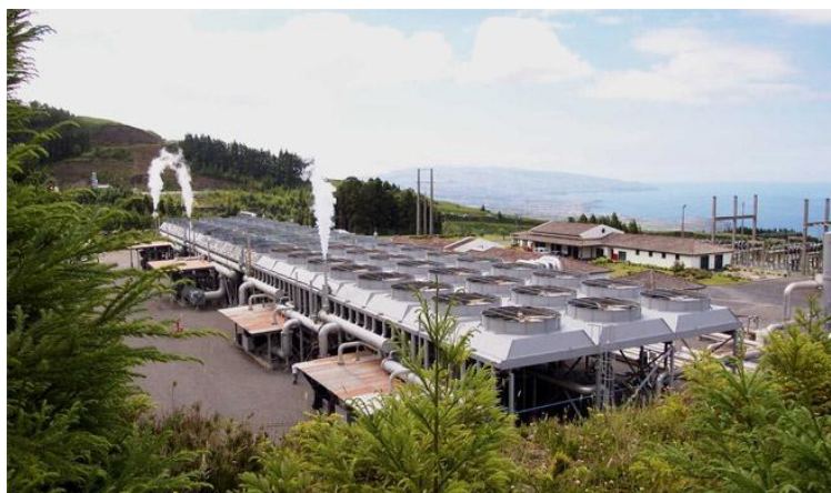
Figura 15: Central Geotérmica da Ribeira Grande [8].
