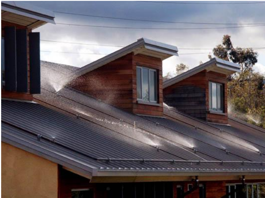
Figura 5 - Arrefecimento por convecção e radiação podem ser integrados em conjunto para aumentar a capacidade de arrefecimento [13].
