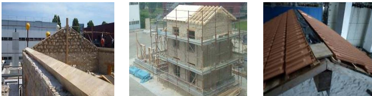
Figura 33: Construção da estrutura da cobertura. Fonte: [75].
