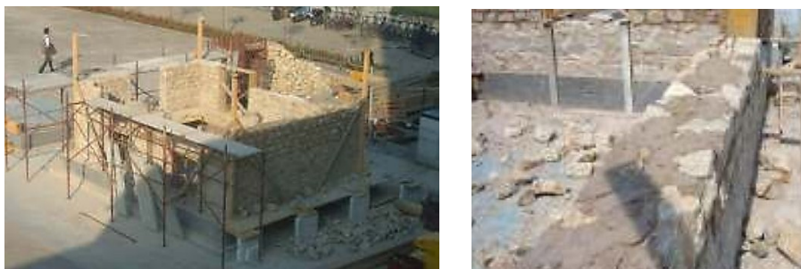
Figura 31: Fase construtiva das paredes de alvenaria. Fonte: [75].
