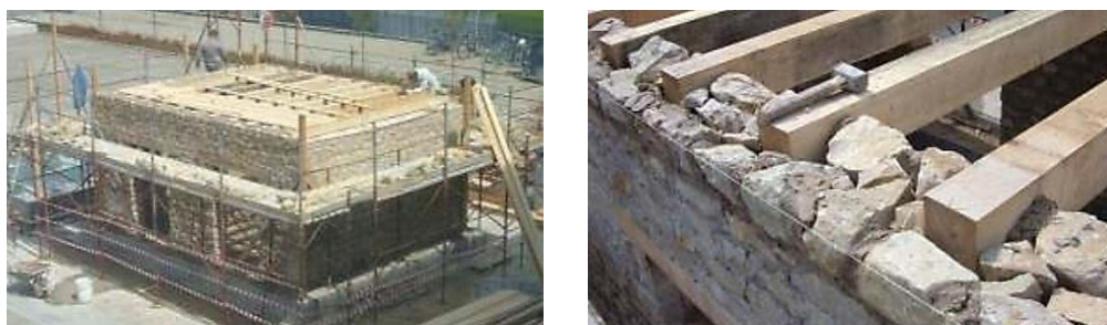
Figura 32: Construção do pavimento intermédio. Fonte: [75].
