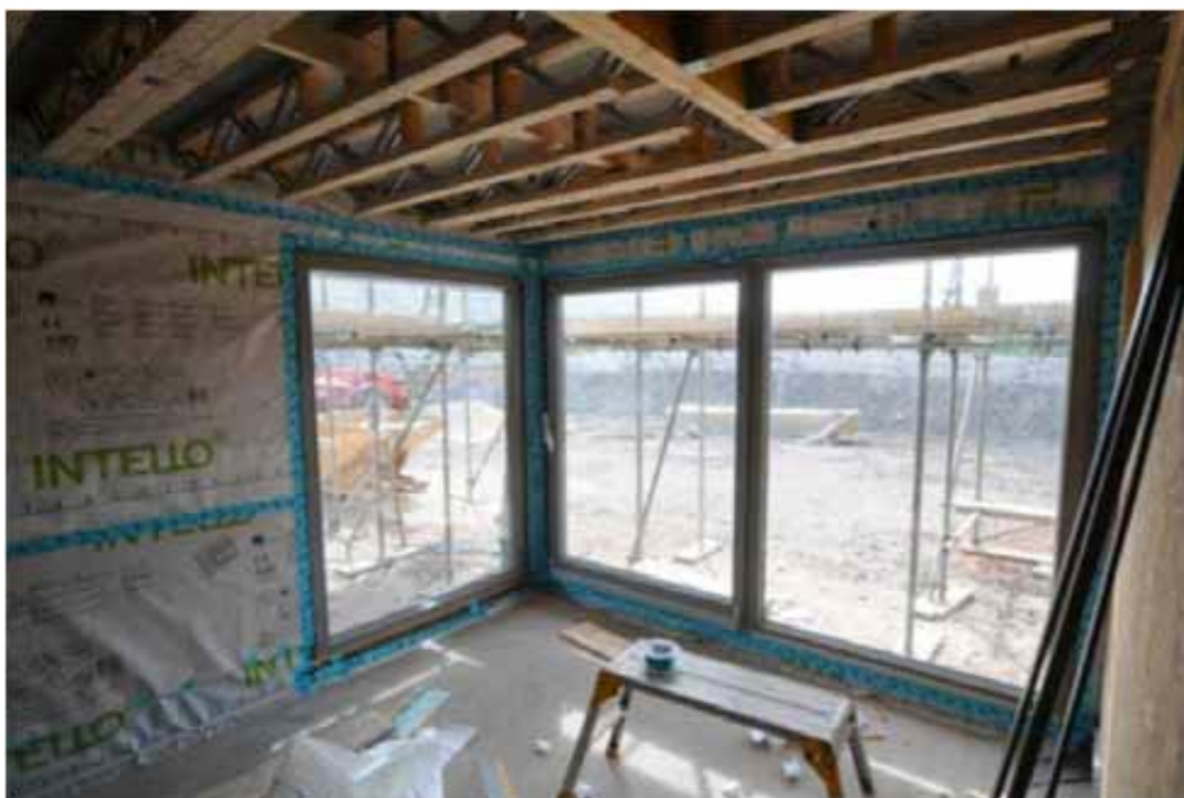
Figura 3.5 – Membrana impermeável (MCLEOD et al., 2006).
