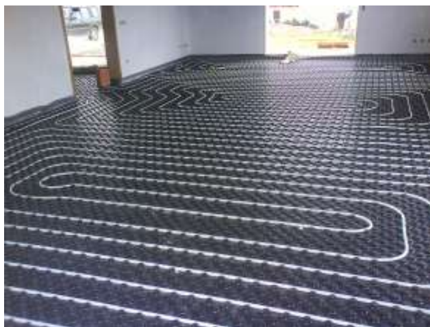
Figura 2.12 – Piso radiante (CONSTANTINO, 2010).
