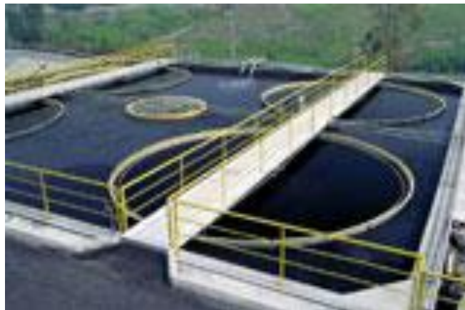
Figura 3.6 Funcionamento da ETAR de Alcântara, a céu aberto (Fonte: Ambiente online , 2012)
