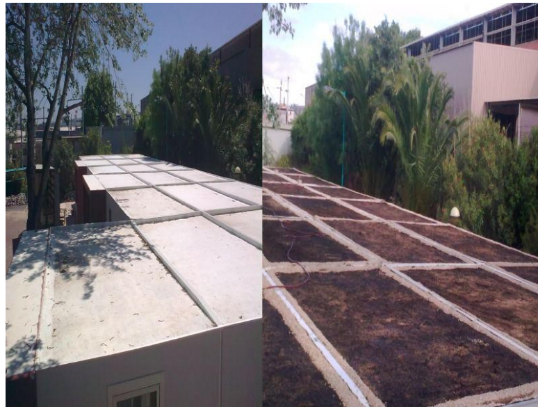
Figura 3.1 Cobertura da EMEF antes da cobertura e na fase de implementação (Fonte: Sunergetic, 2009)
