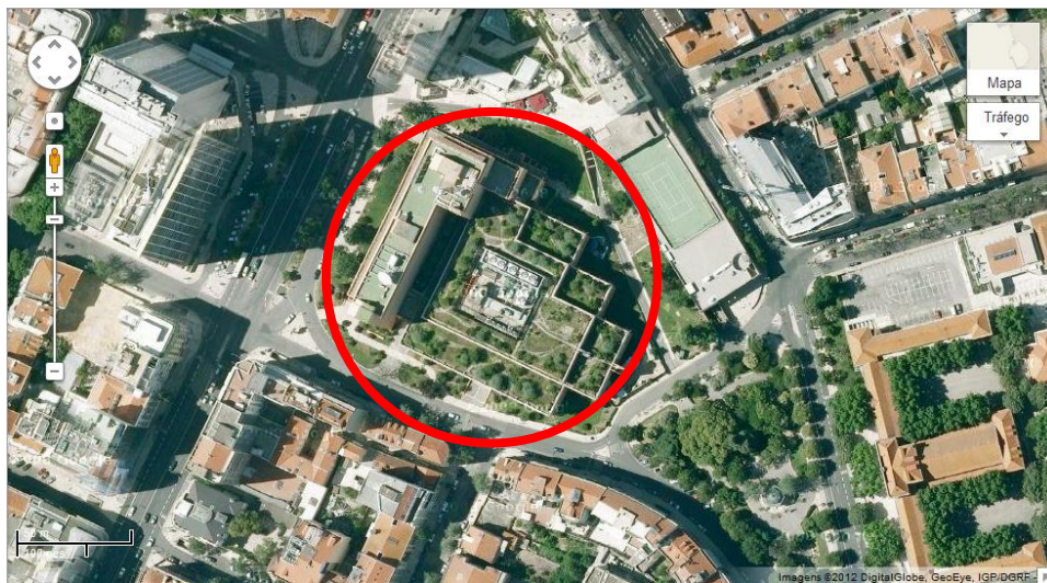
Figura 3.3 Localização do Edifício PT Picoas (Adaptado de Google maps, 2012)
