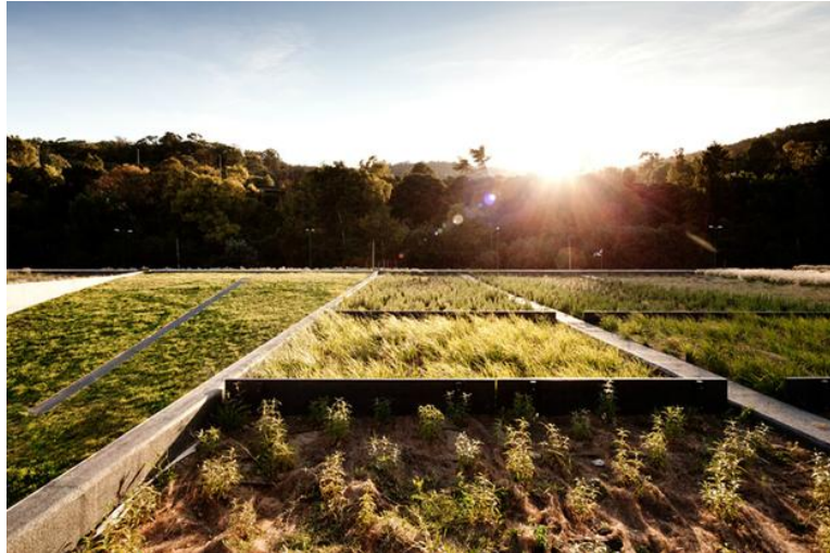
Figura 3.9 Vegetação presente na cobertura da ETAR (Fonte: Ultimas, 2012)
