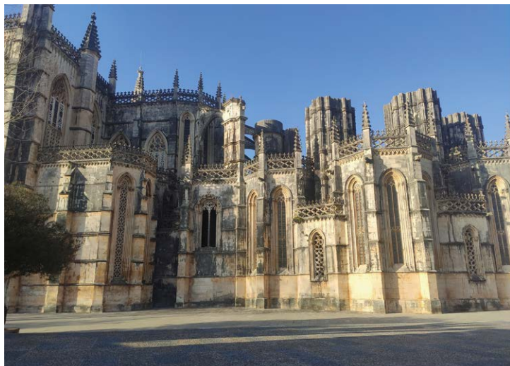
Figura 1 Fachada lateral do Mosteiro da Batalha, 2023, autoria: Sofia Santos.
