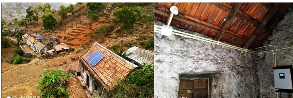
Figura 6.88 - Instalação de kits solares fotovoltaicos (Fonte: Centro de Energias Renováveis e Manutenção Industrial, CERMI).
