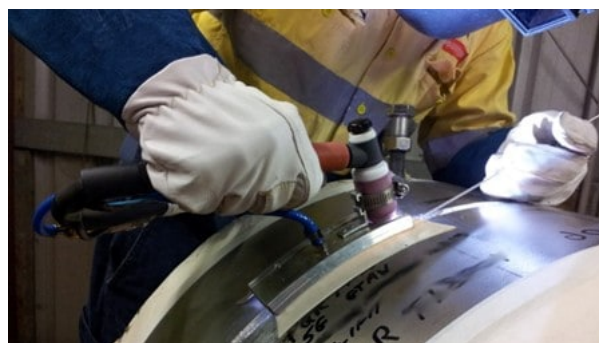
Figura 2.8: Extra proteção de gás para soldadura de titânio.
