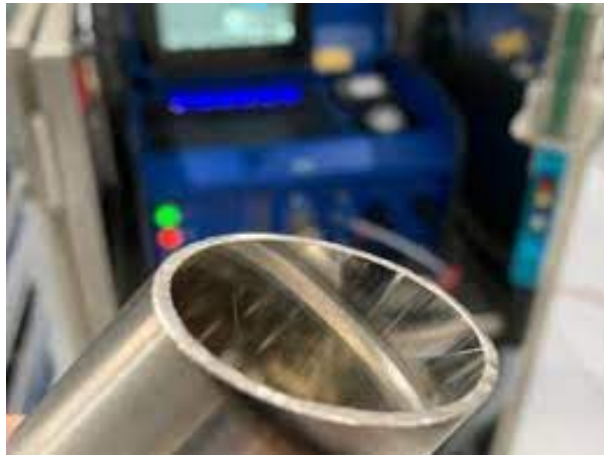
Figura 2.3: Processo de soldadura TIG, numa tubagem para a indústria farmacêutica.
