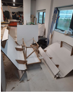
Figura 33 - Painéis da carcaça antes de montados na estrutura.
