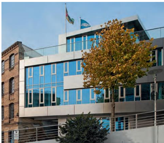
Figura 6 - Edifício de escritórios em Hamburgo.
