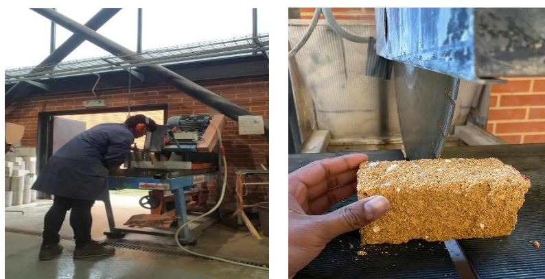
Figura 11 - Processo de corte dos adobes existentes
