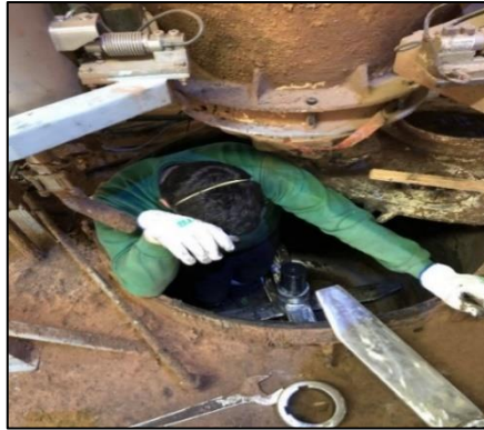
Figura 30 - Limpeza de misturador (desmotivação e cansaço dos aperadores)
