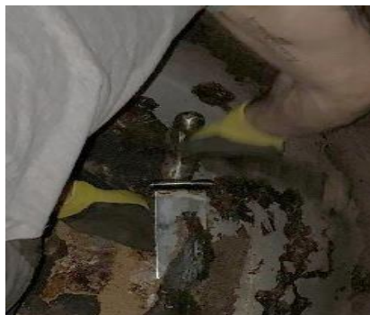
Figura 29 - Limpeza de misturador (utilização de raspador manual e martelo)
