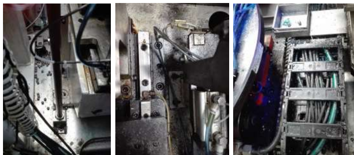
Figura 4.5: Estado inicial dos equipamentos.
