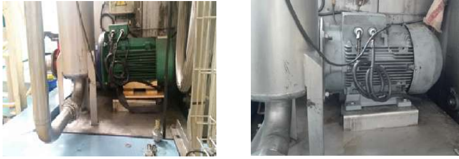
Figura 4.16: Motor da máquina 2288, durante a intervenção à esquerda e no fim da intervenção à direita.
