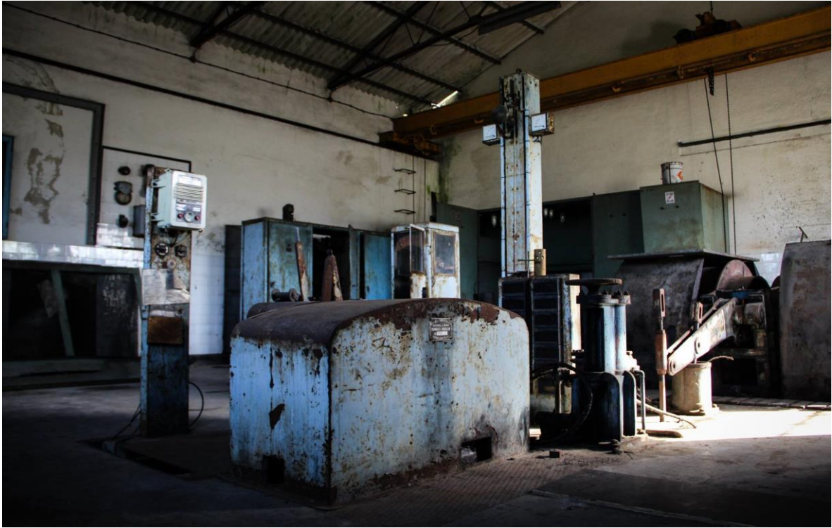
Figura 33 - 1º andar do Poço de Germunde, “Casa das Máquinas”
