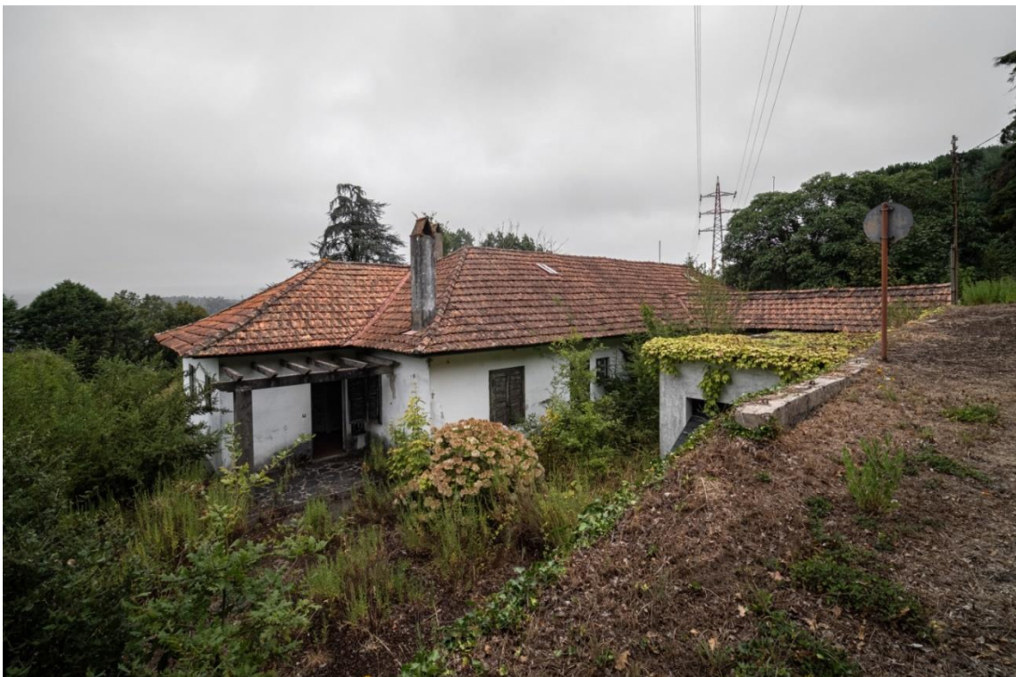
Figura 32 – Casa para trabalhadores dos quadros técnicos
