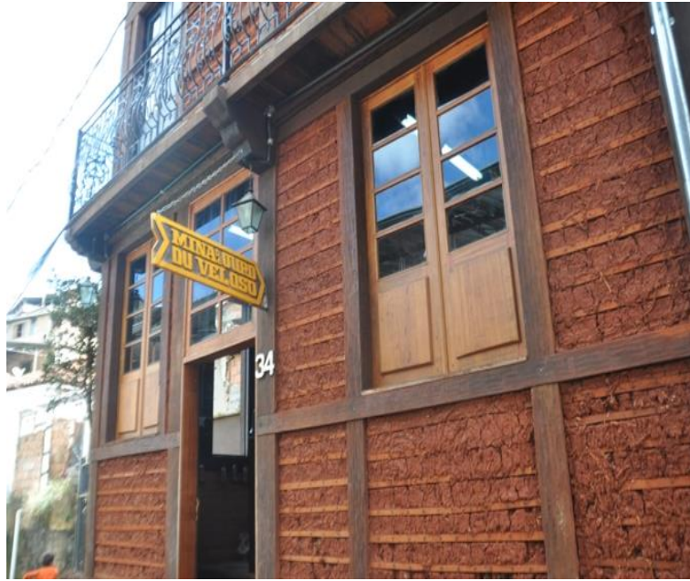
Figura 8- Entrada do centro de visitantes da mina do Veloso Fonte: Teixeira (2015)
