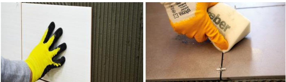
Figura 1.1- Aplicação do cimento-cola para aplicação de cerâmicos em parede (à esquerda) e em pavimentos (à direita)
