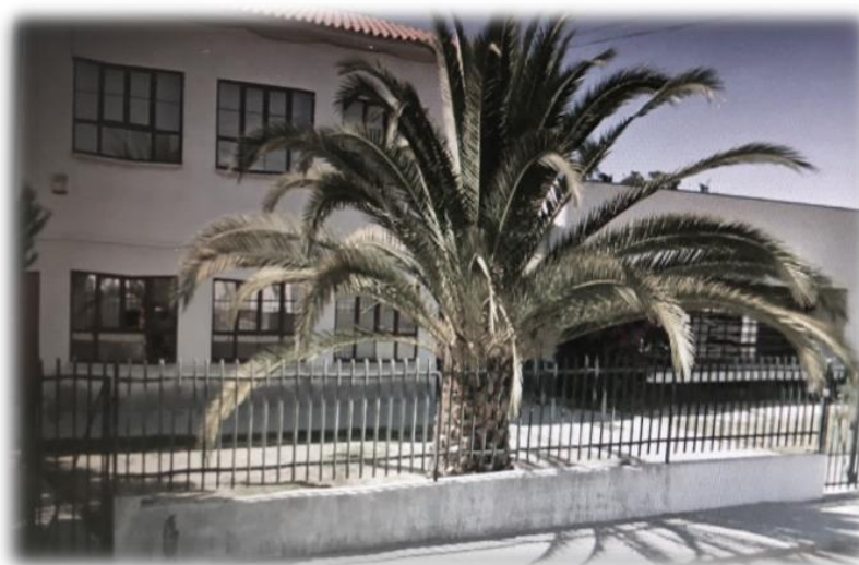
Figura 5 – Fachada da escola básica
