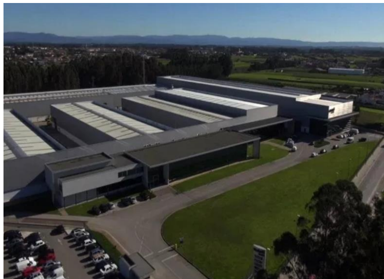
Figura 2.5- Instalações atuais Do Group Motofil. Fonte: Motofil Group.
