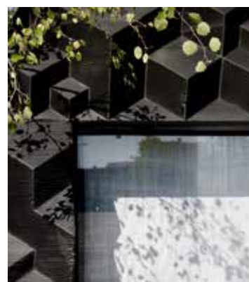
Figura 3.16 Pormenor da superfície da microcasa em PLA. Foto de Ossip ( https://houseofdus.com/project/urban-cabin/ )
