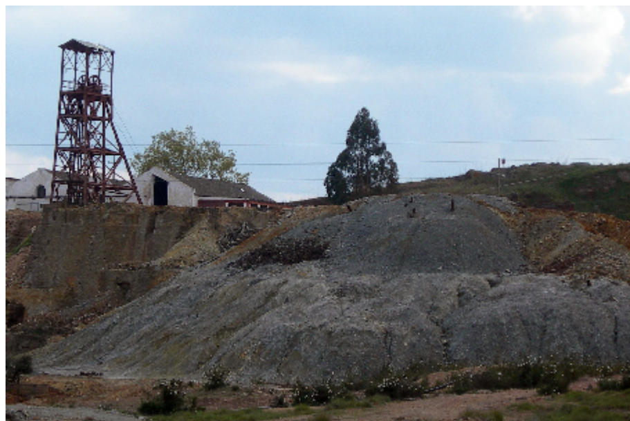
figura 1.3 Escorrência das águas das chuvas nas escumbras
