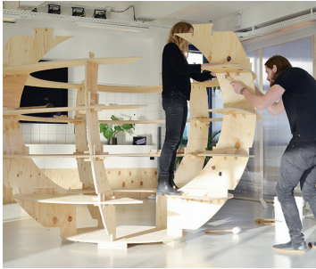
Figura 41 - Processo de montagem da estrutura do Growroom.
