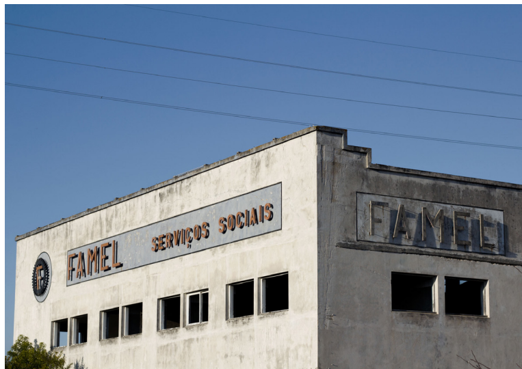
fig. 54 - Edifício dos Serviços Sociais da empresa Famel, 2017
