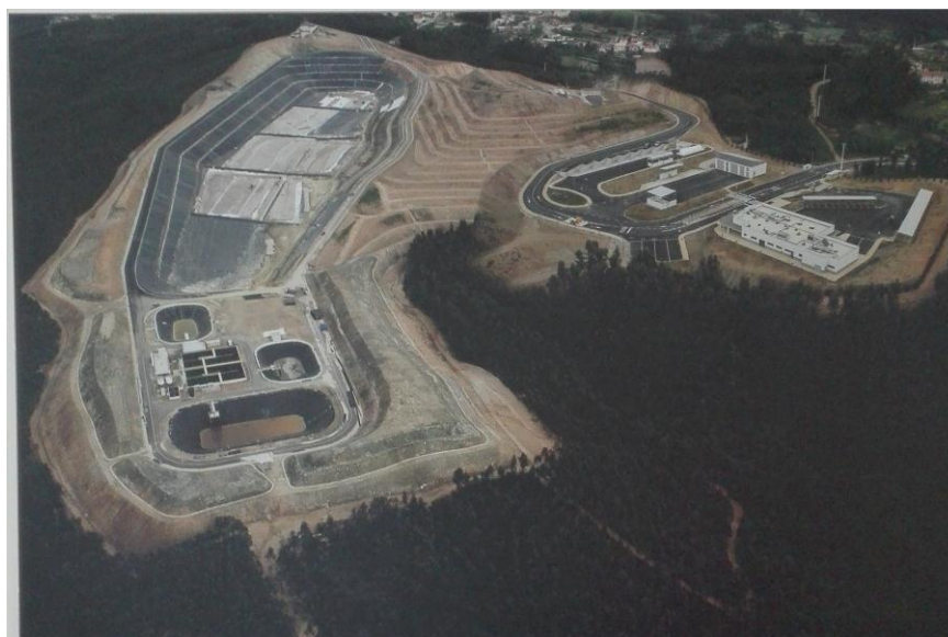
Figura 3.11 - Aterro do Gestal, situado em Canedo, Santa Marai da Feira.
