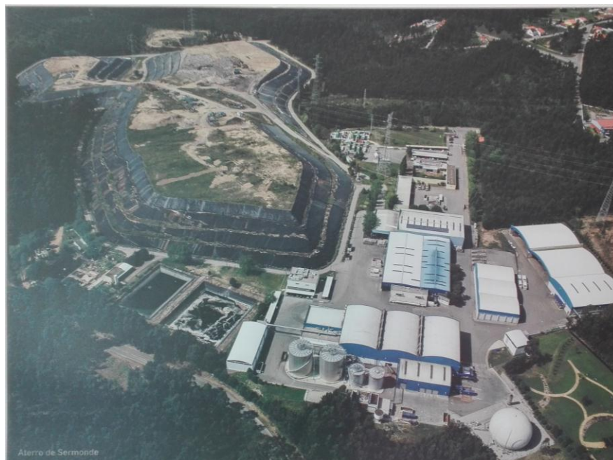
Figura 3.10 – Aterro situado em Sermonde, Vila Nova de Gaia.
