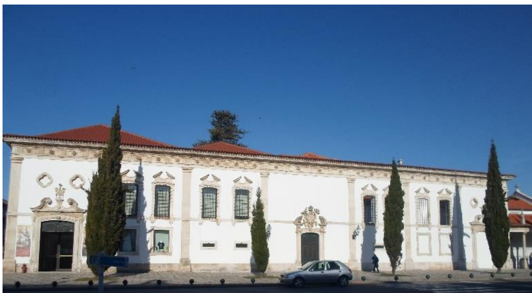
Figura 4.1 – Fachada do Museu de Aveiro
