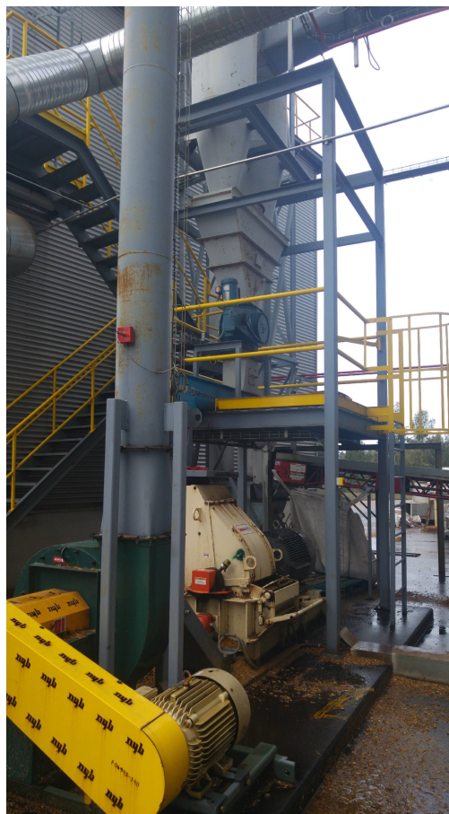
Figura 9: Duplo ciclone e segundo moinho de martelos do processo produtivo da YGE.
