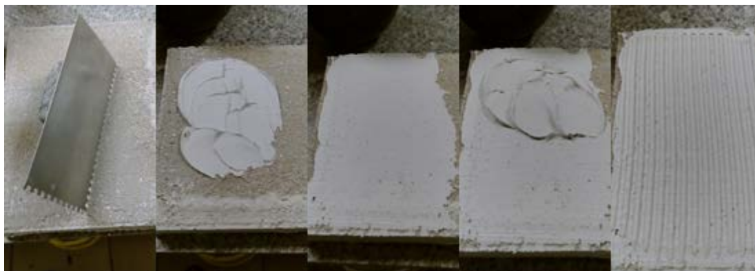
Figura 6 - Aplicação de uma argamassa de colagem
