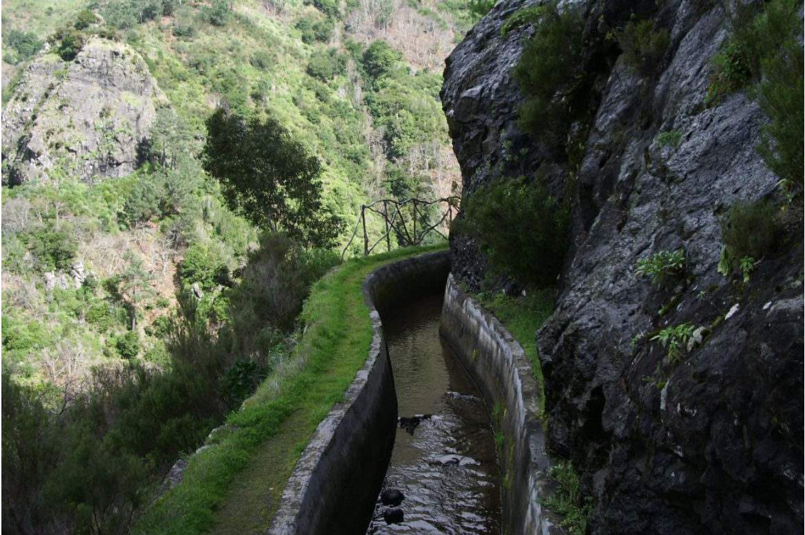
Imagem 84: "Levadas" canais de águas para destino de rega agrícola, imagem de autor desconhecido
