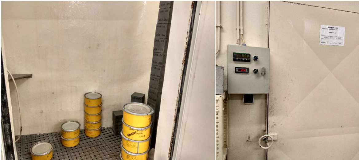
Figura 40 – Câmara de cura onde se guardam os provetes cúbicos de betão até à data de ensaio.
