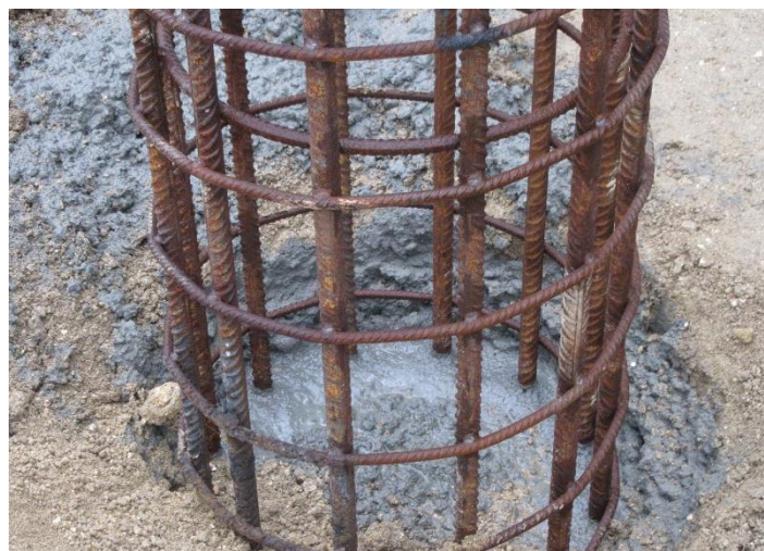
Figura 3.5 - Pormenor de uma armadura electrossoldada (fotografia da autora)
