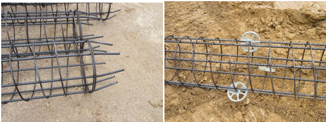
Figura 5.12 - Armadura afunilada (esquerda) e com presença de espaçadores (direita) (fotografias da autora)
