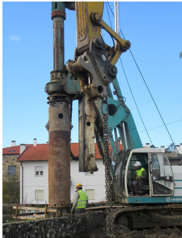
Figura 5.19 - Introdução do tubo moldador (fotografia da autora)
