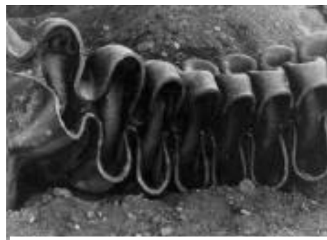
Figura 2.9 - Deformação presente numa estaca de aço (Pedro, s.d.)
