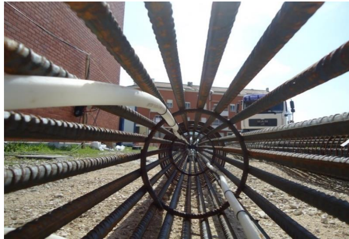
Figura 3.4 - Pormenor interior da armadura (imagem cedida pela dst na Universidade de Aveiro)
