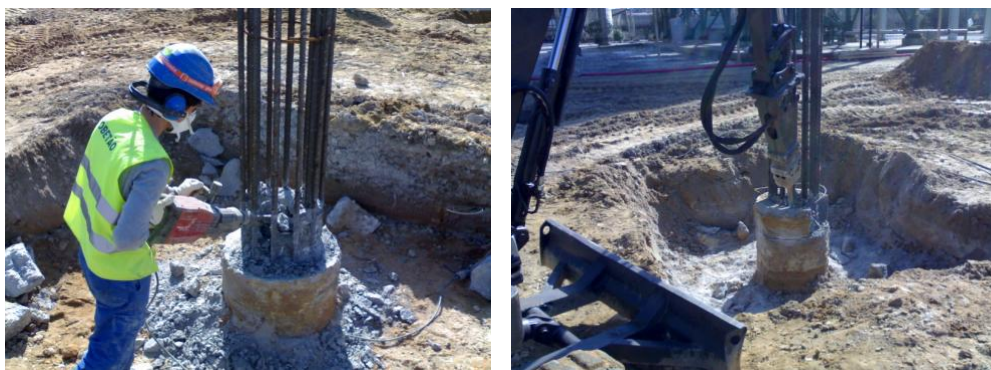
Figura 3.13 - Demolição do restante material da cabeça da estaca (Hidrobetão - Corte, Furação e Demolição, Lda., s.d.)
