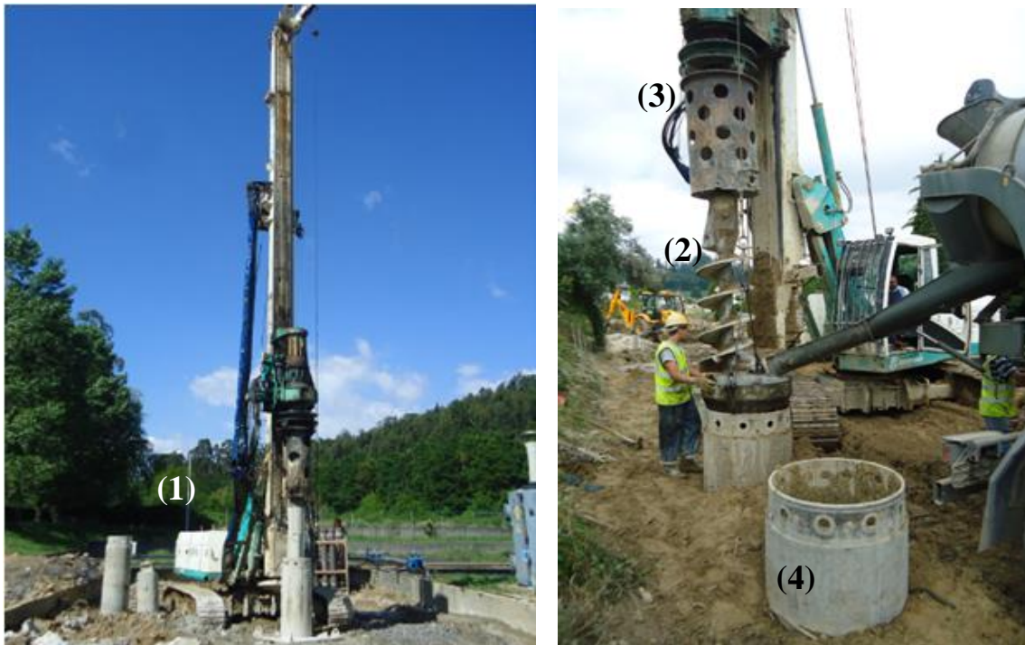
Figura 3.8 – Furação (esquerda) e betonagem (direita) das estacas pelo método de tubo moldador recuperável com (1) máquina de estacas Casagrande; (2) Vara telescópica Kelly; (3) cabeça de rotação; (4) tubos moldadores recuperáveis (imagens cedidas pela dst)
