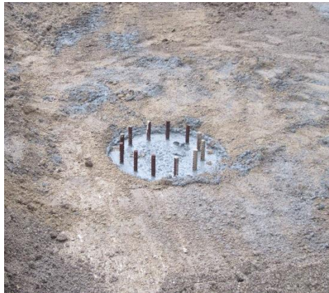
Figura 5.11 - Aspeto final da estaca vista à superfície (fotografia da autora)
