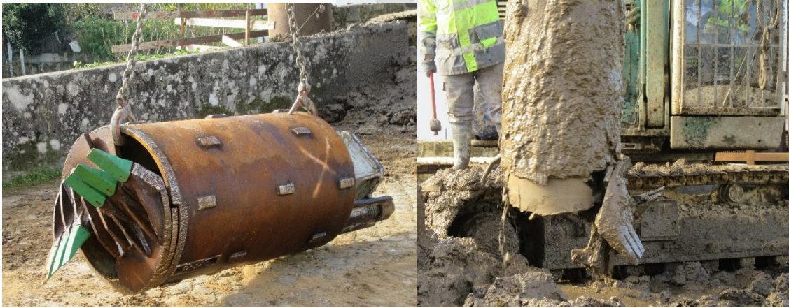
Figura 5.20 - Pormenor da base da Limpadeira (esquerda) e material a ser extraído no interior da Limpadeira (direita) (fotografia da autora)
