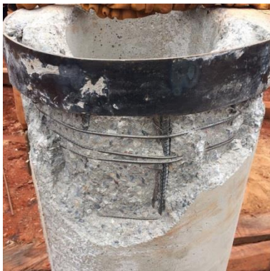
Figura 2.10 – Resultados de má qualidade do betão de uma estaca (Neves, 2010)
