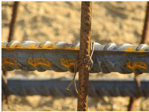
Figura 3.7 - Pormenor da armadura atada (fotografia da autora)
