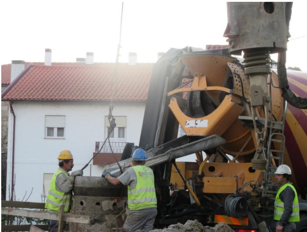
Figura 5.24 - Processo de betonagem (fotografia da autora)
