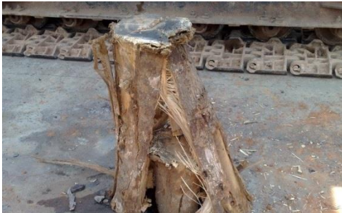
Figura 2.8 - Estaca de madeira com o topo destruído (Neves, 2010)
