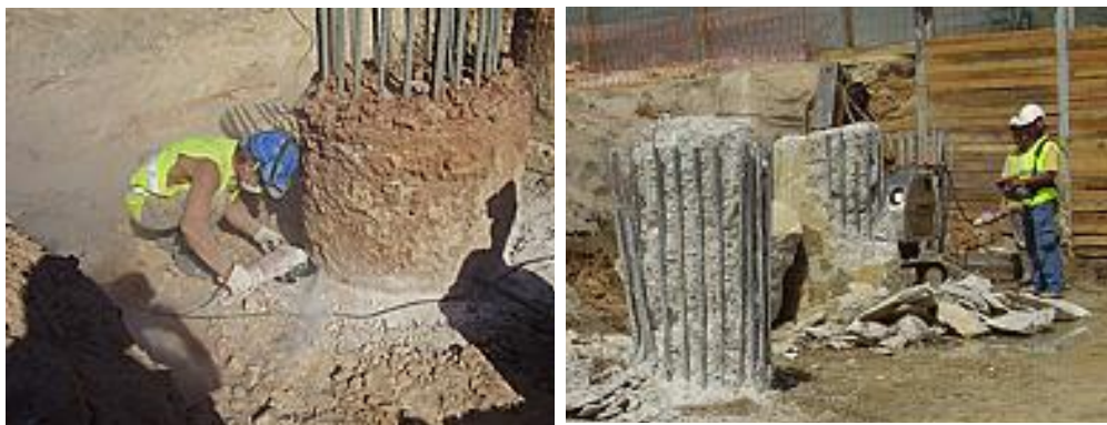
Figura 3.12 - Furação da estaca com torna para posterior arrebentamento (Hidrobetão - Corte, Furação e Demolição, Lda., s.d.)
