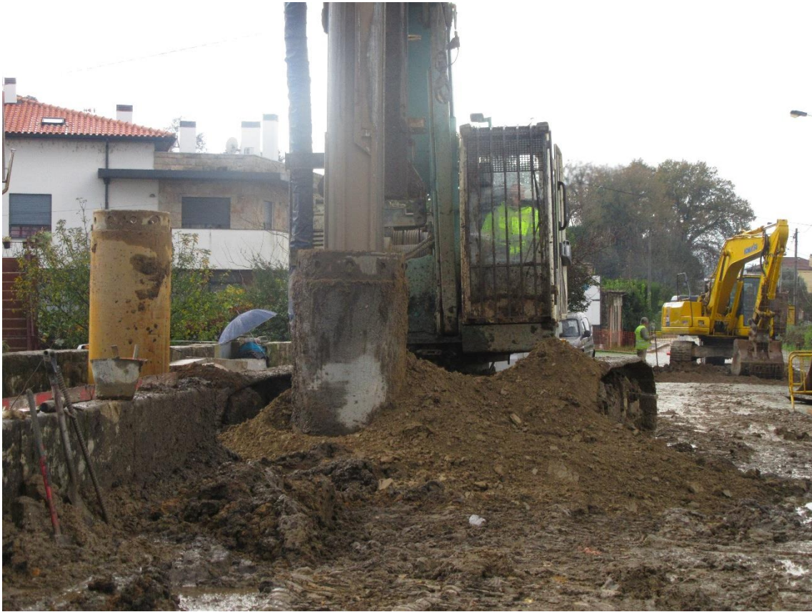
Figura 5.27 - Material extraído seco do fundo do furo (fotografia da autora)
