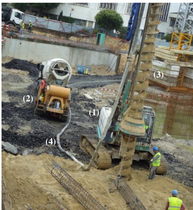
Figura 3.6 - Equipamento usado para realizar estacas moldadoras de trado contínuo: (1) máquina de estacas Casagrande; (2) bomba de betão; (3) trado contínuo oco com o diâmetro e comprimento nunca inferior aos da estaca; (4) tubagem flexível de ligação da bomba de betão à cabeça de rotação da máquina (imagem cedida pela dst)
