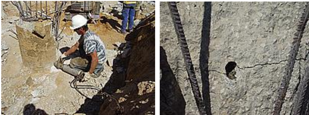
Figura 3.11 - Corte pela periferia da estaca (esquerda) e demolição de toda a periferia da estaca até à visualização da armadura (direita) (Hidrobetão - Corte, Furação e Demolição, Lda., s.d.)
