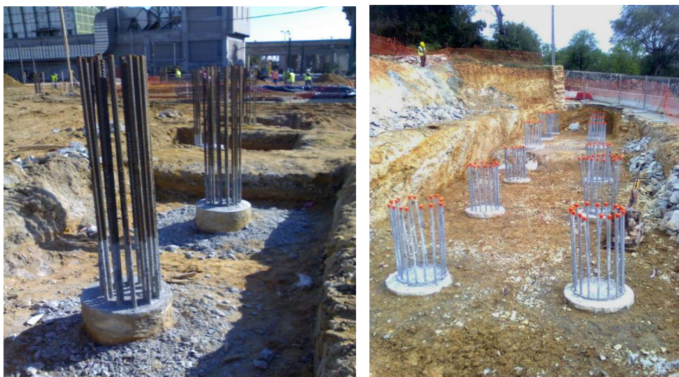
Figura 3.14 - Aspeto final após o saneamento das estacas (Hidrobetão - Corte, Furação e Demolição, Lda., s.d.)
