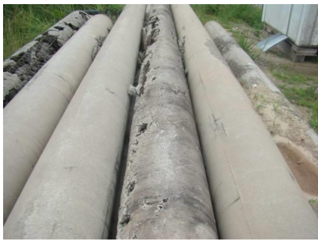
Figura 3.15 - Estacas após ensaio de carga destrutivo (Neves, 2010)
