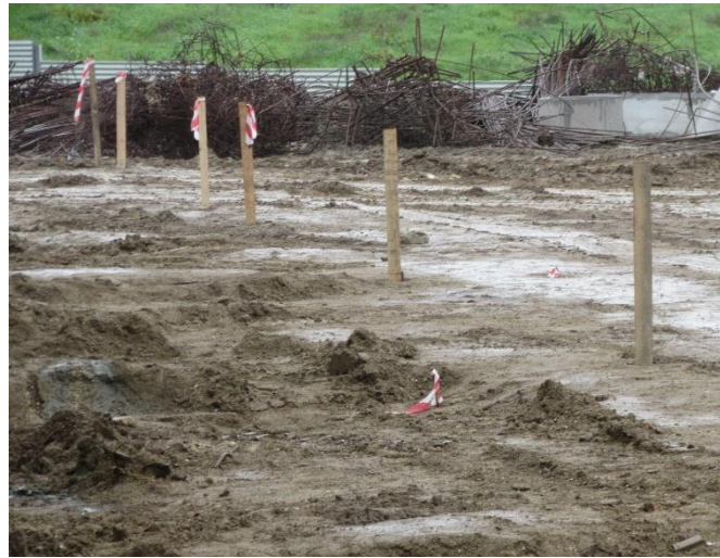
Figura 5.6 - Marcação do local das estacas (fotografia da autora)
