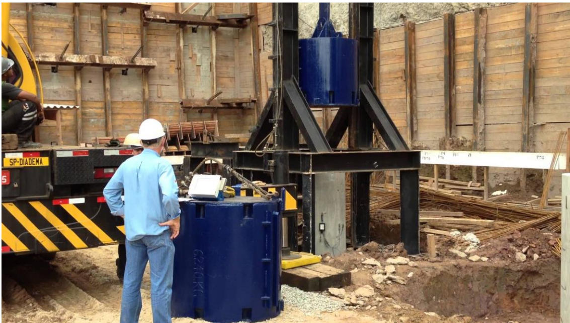
Figura 3.17 - Ensaio de Carga Dinâmico em obra aplicado numa estaca ( http://www.youtube.com/ensaio cargadinamico )
