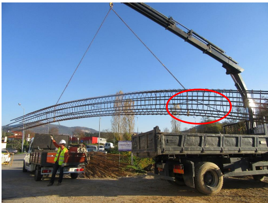
Figura 5.22 - Armadura atada a ser içada c/ cristas de cavalo (vermelho) (fotografia da autora)
