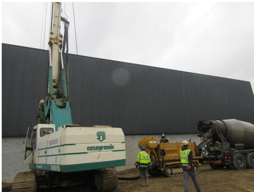
Figura 5.8 - Equipamento para o processo de betonagem (fotografia da autora)
