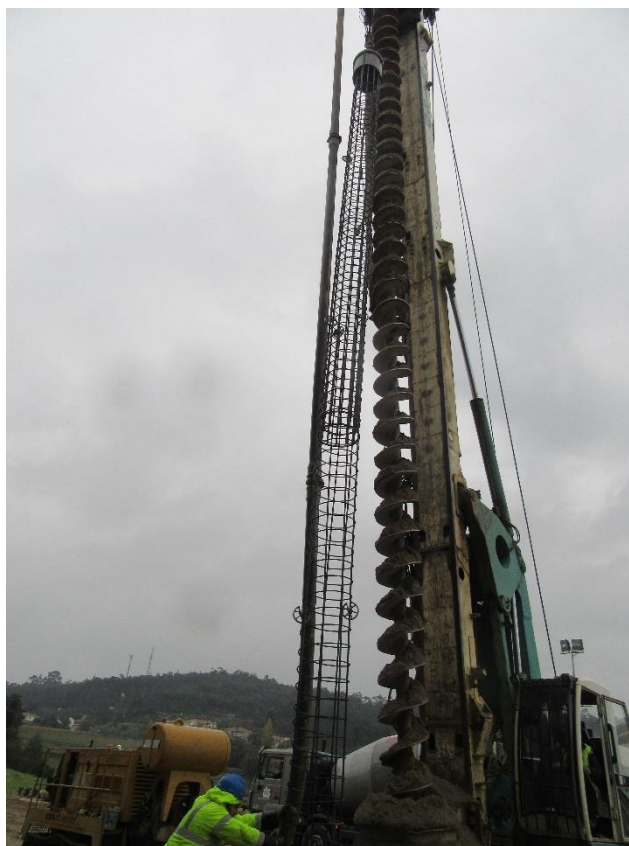
Figura 5.10 - Armadura a ser introduzida no furo da estaca (fotografia da autora)
