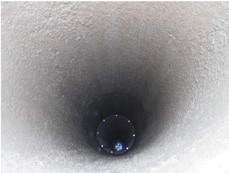
Figura 5.25 - Vista interior do furo com armadura (fotografia da autora)
