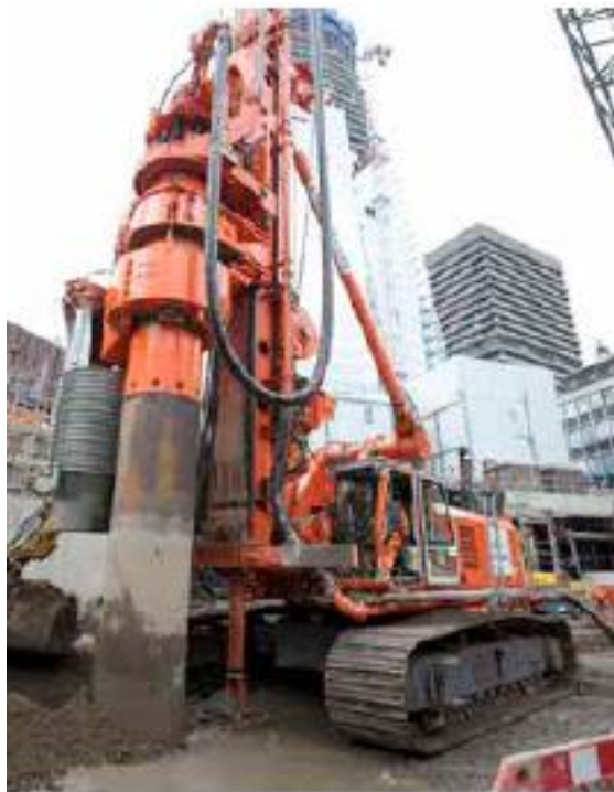
Figura 2.2 - Método de Cased CFA (Cementation Skanska, 2013)
