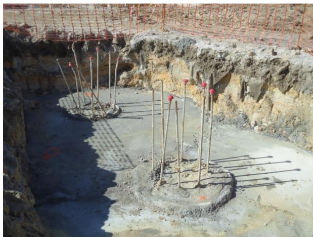
Figura 3.10 - Aspeto visual final da estaca após a realização do saneamento (imagem cedida pela dst)
