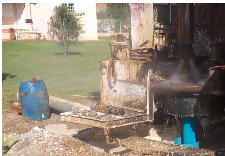
Figura 5.2 - Martelo em posição inoperante
