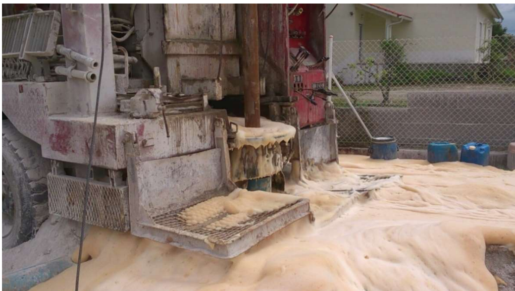
Figura 5.10 - Espumas de sondagem ascendendo com os cuttings resultantes da perfuração
