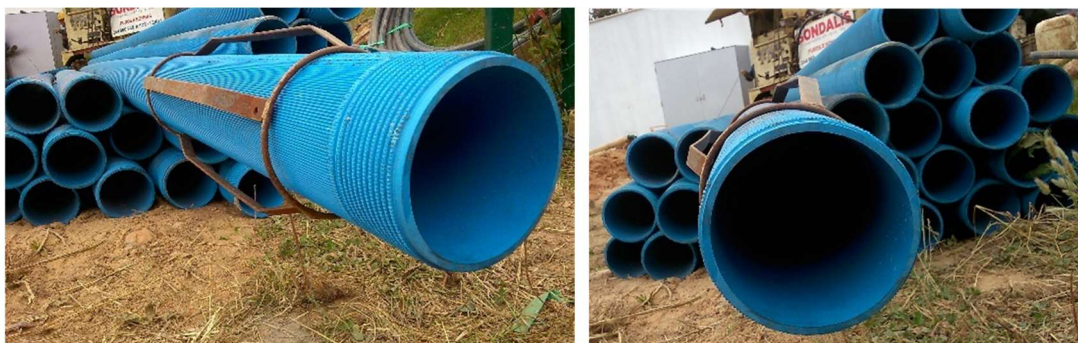
Figura 5.16 - Centralizadores
