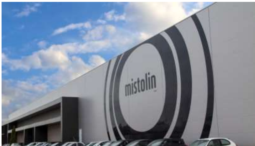
Figura 1: Fachada atual da empresa Mistolin S.A.
