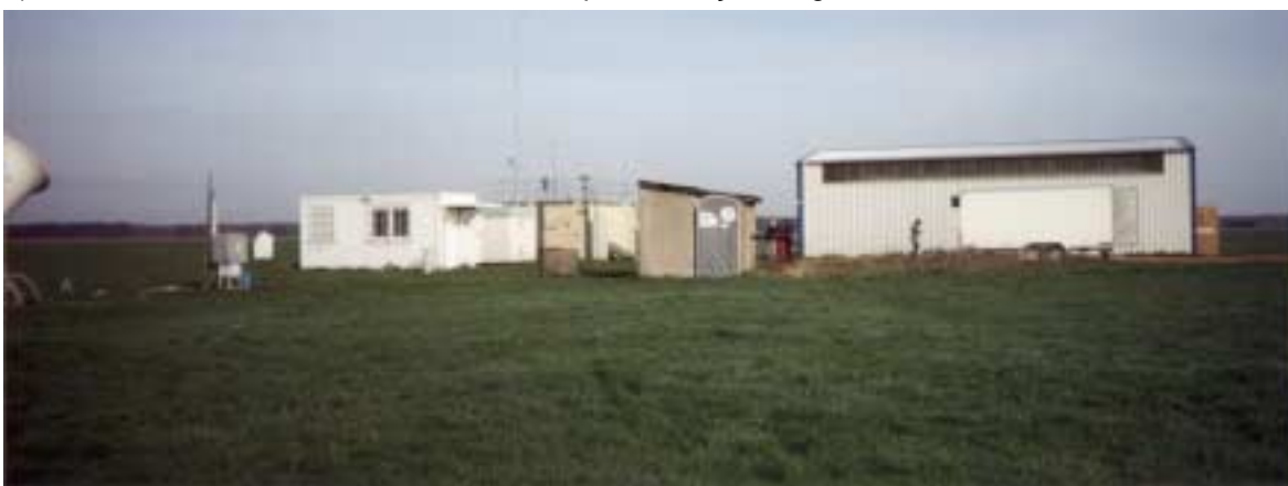
b) Edifícios para abrigo de equipamento de medição e armazenamento de material
